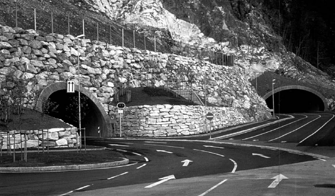
07 Proyecto para un embarcadero en Noruega. "El proyecto resuelve la articulación entre el túnel, las vías de acceso y la zona de embarque. El uso de la piedra local y el desdoblamiento de la carretera tiende a contextualizar la intervención en el paisaje". Molde. "The Project handles the articulation of the tunnel, the slip roads and the boarding area. The use of local stone and the doubling of the routes tend to contextualize the intervention in the landscape" (N.p.t. Inglés original)
