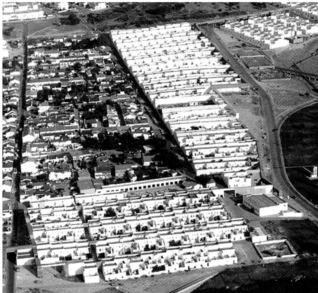
06 Vista aérea de la Quinta de la Malagueira, Alvaro Siza.
