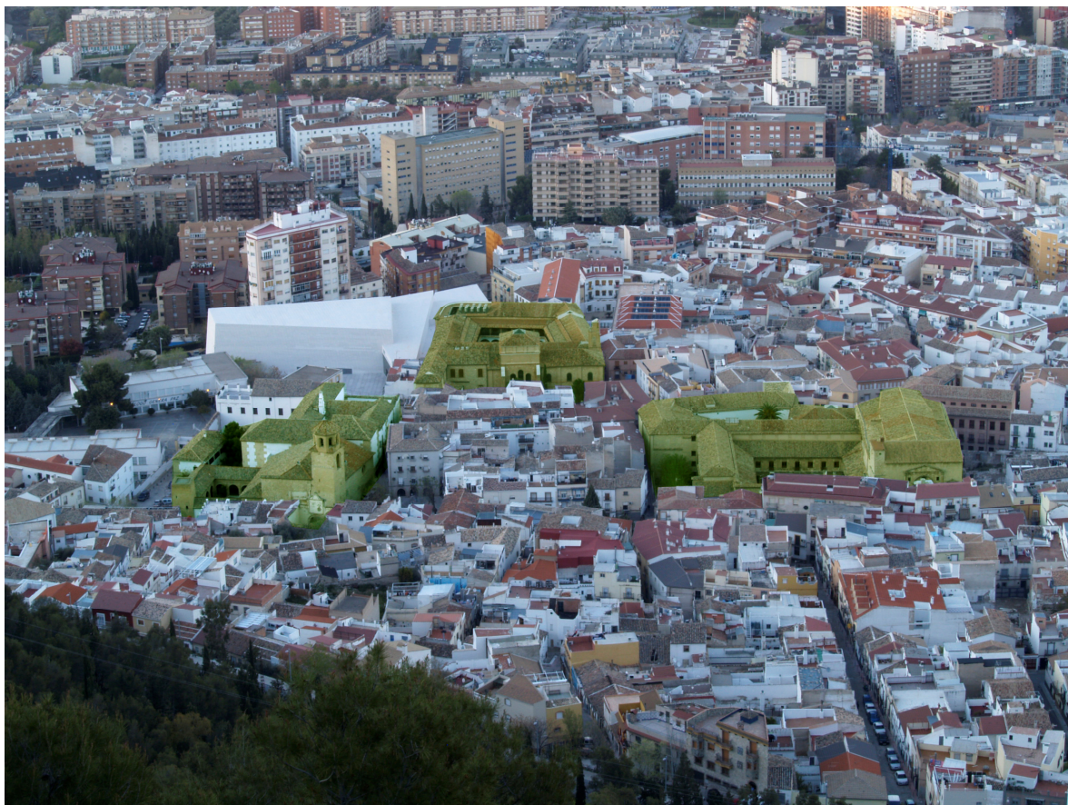
Saturación de fundaciones en las antiguas collaciones de La Magdalena, San Miguel y San Juan
