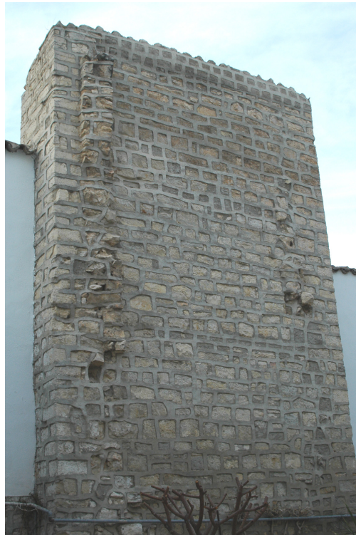
Restos de la torre de Santa Cruz en Santa Clara
