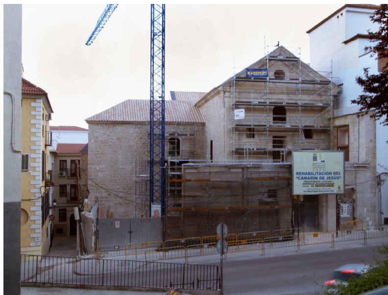
Iglesia y Capilla-Camarín del convento de S. José
