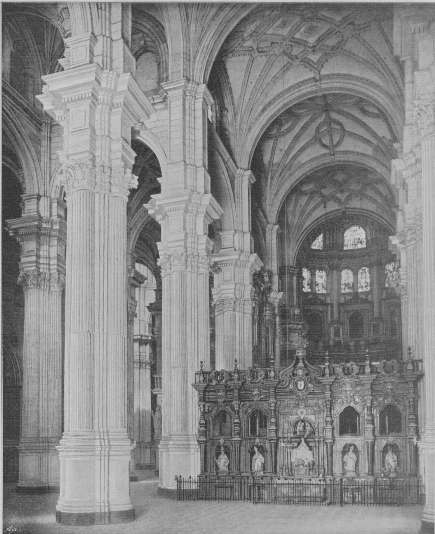
NAVE PRINCIPAL DE LA CATEDRAL DE GRANADA
