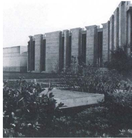
465 Pórtico previo a la capilla. (f: Enzo Renai)
