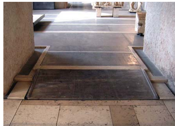
315 Canal perimetral. Puente.
