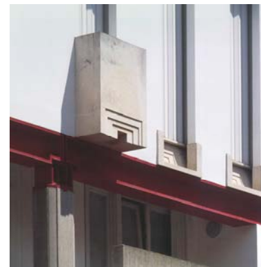
269 Detalle de fachada. (f: Vaclav Sedý)
