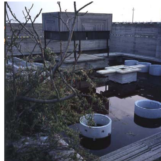
516 Estanque. Profundidad construida (f: AGP)
