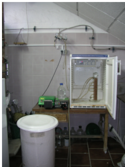
Fig. 11.- Filtro sumergido una vez conectado con el agua subterránea contaminada
