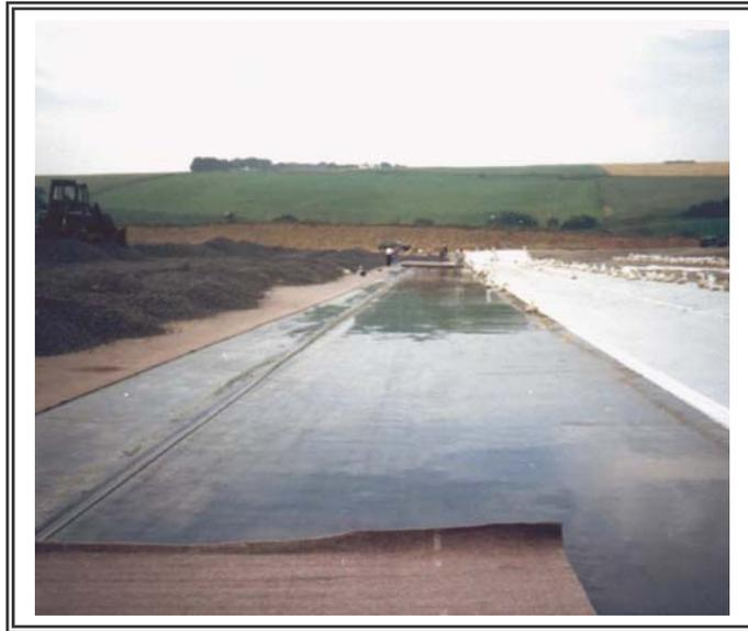
**Figura 6. Barreras impermeables de fondo**
