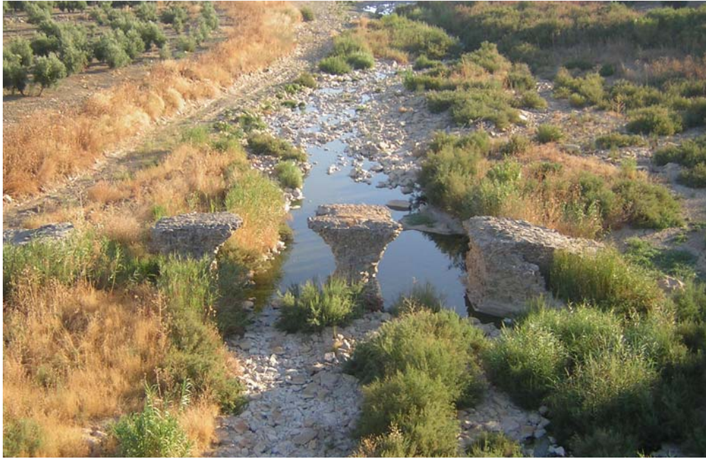
Figura 1: Hormigón en la pila y estribos del puente romano de Porcuna. Probablemente de época republicana (Siglo I a.C)
