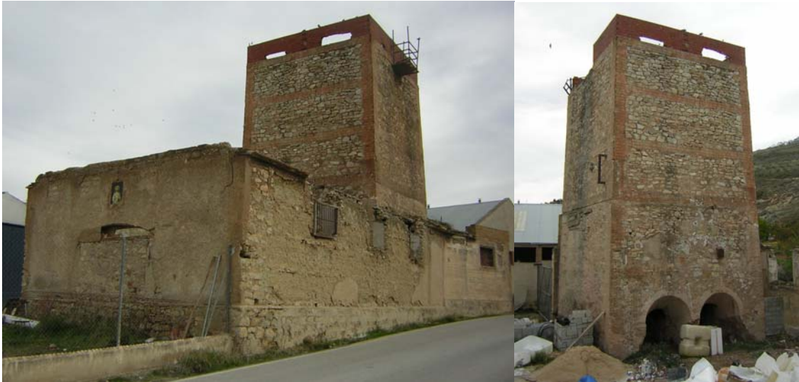
Figura 10: Fábrica de Sáez de Tejada antes de la rehabilitación. Nave con muros de tapiales y torre de hornos con dos hogares.
