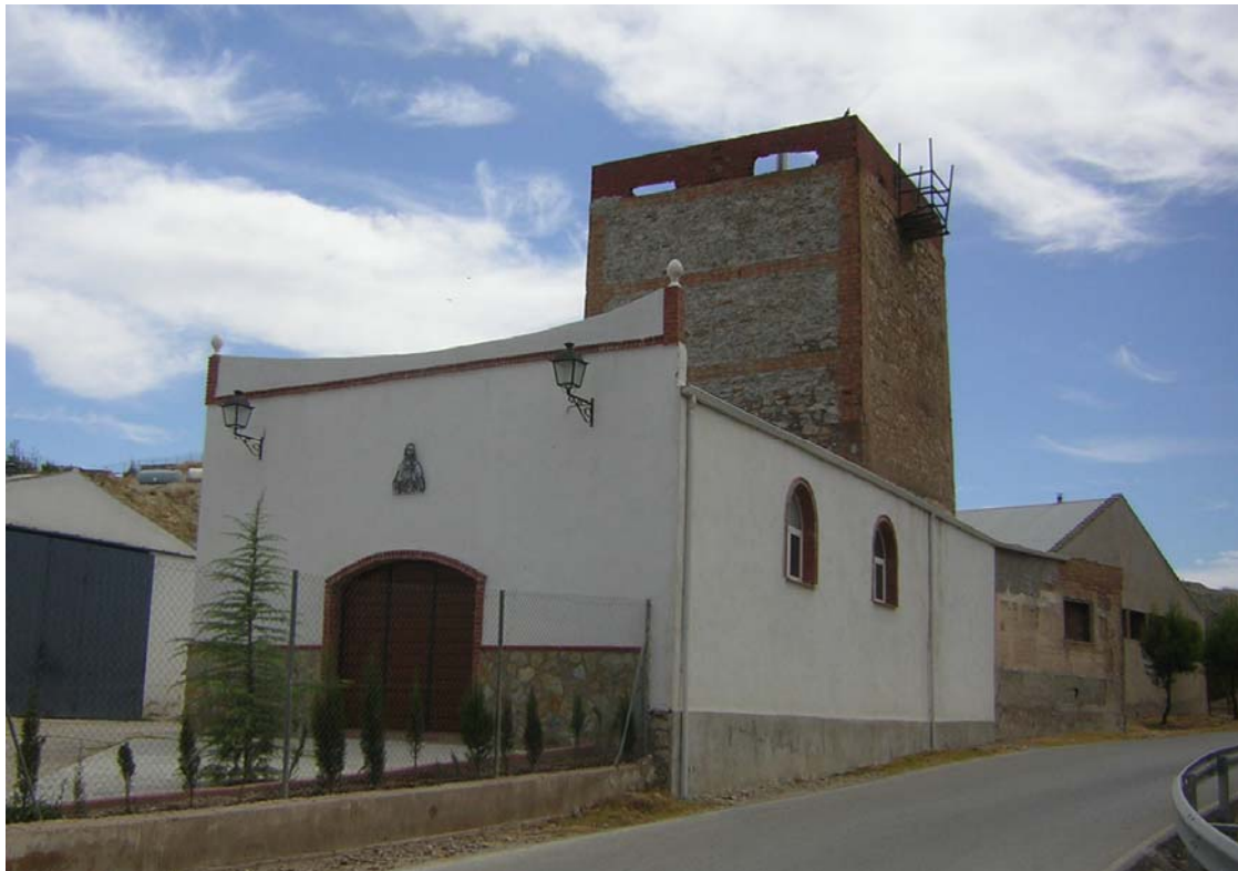
Figura 11: Fábrica de Sáez de Tejada en la actualidad, recuperada para otros usos por su actual propietario.
