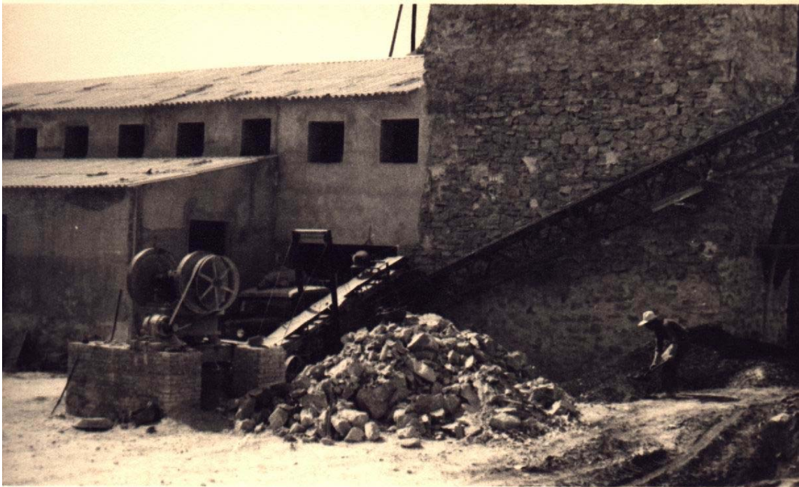
Figura 7: Acopio de piedras, molino de trituración y tolvas de alimentación del horno. Fábrica de Cementos Ríquez de la carretera de Los Villares. Martos, hacia 1960. Cortesía de D. Juan Ríquez Molina
