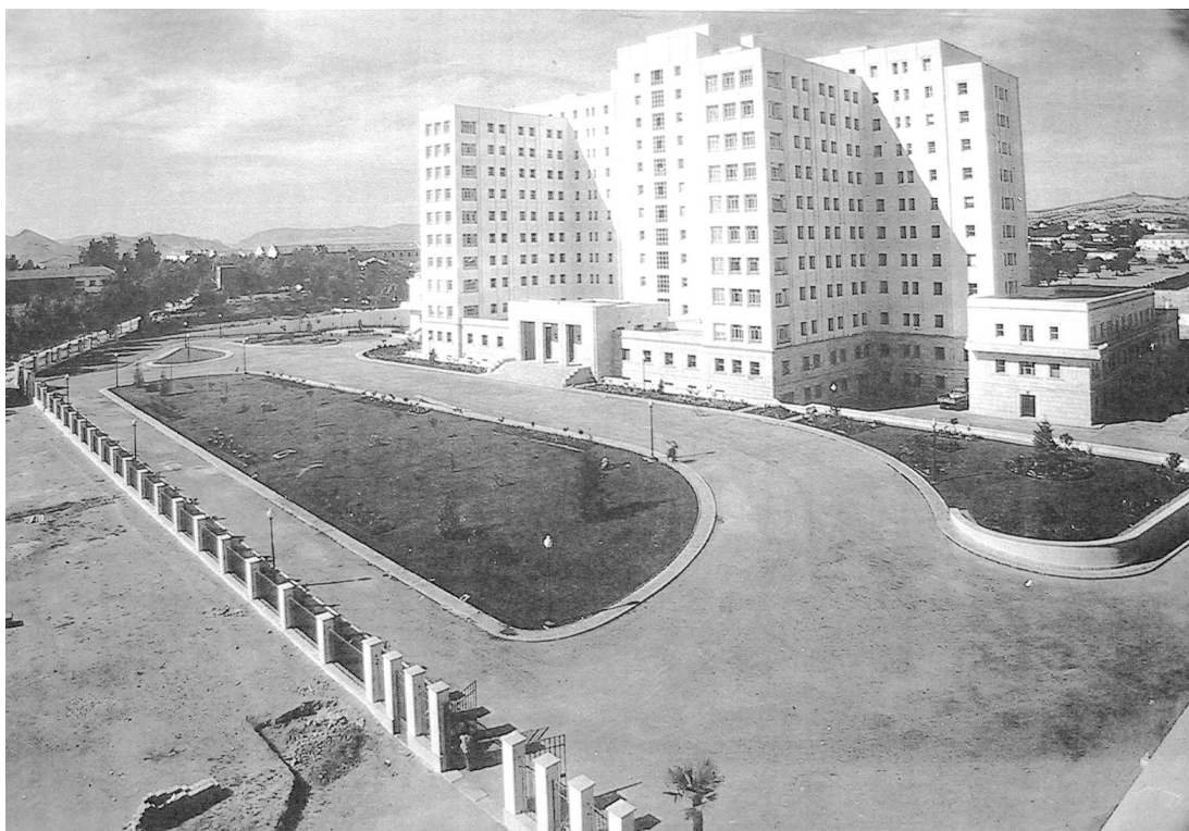
Vista Lateral del edificio de la Residencia Sanitaria Ruiz de Alda. (A. H. U. V. N.)
