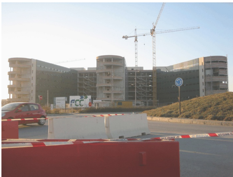
Hospital Clínico en construcción. (J. M. L. G. )
