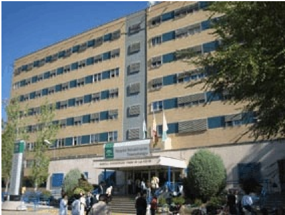
Hospital de Rehabilitación y Traumatología
