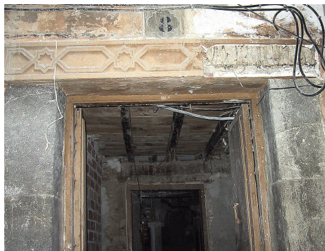
Distintos elementos encontrados en la restauración de una de las casas que posiblemente pertenecieran al hospital de Peregrinos.
