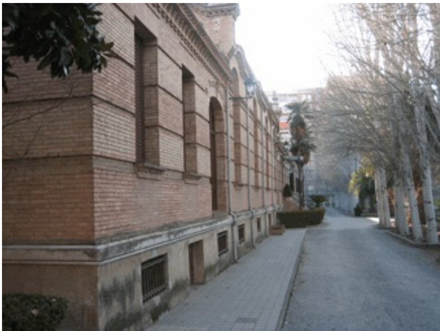
Detalle de la fachada del Hospital de la Caridad y el Refugio.
