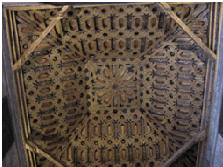
Armadura de la escalera. (J. M. L. G.)
