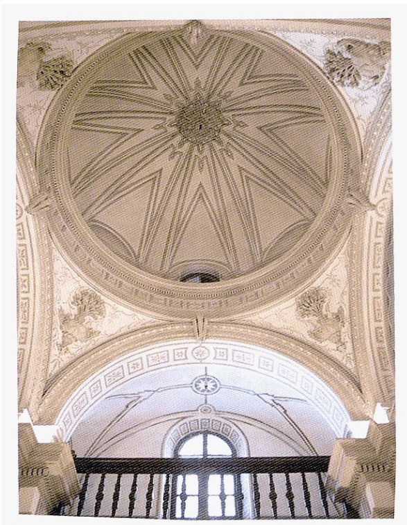
Bóveda de la capilla
