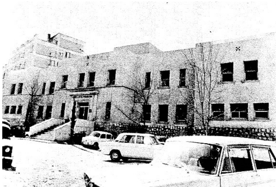
Pabellón de Psiquiatría en obras. (M. G. G.)
