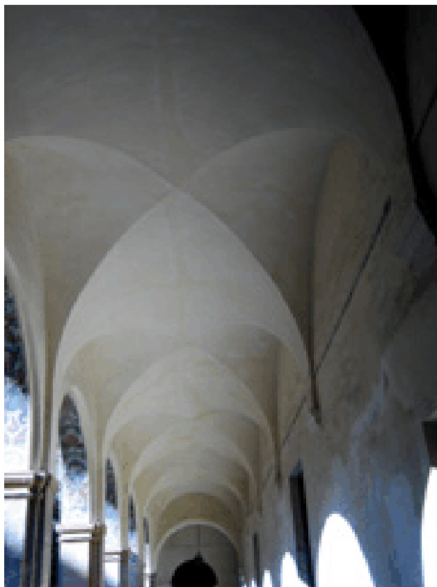
Galería del segundo patio. (J. M. L. G.)
