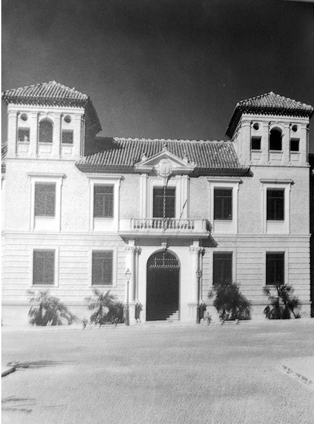
Puerta del pabellón principal. (A. D. P. G.)
