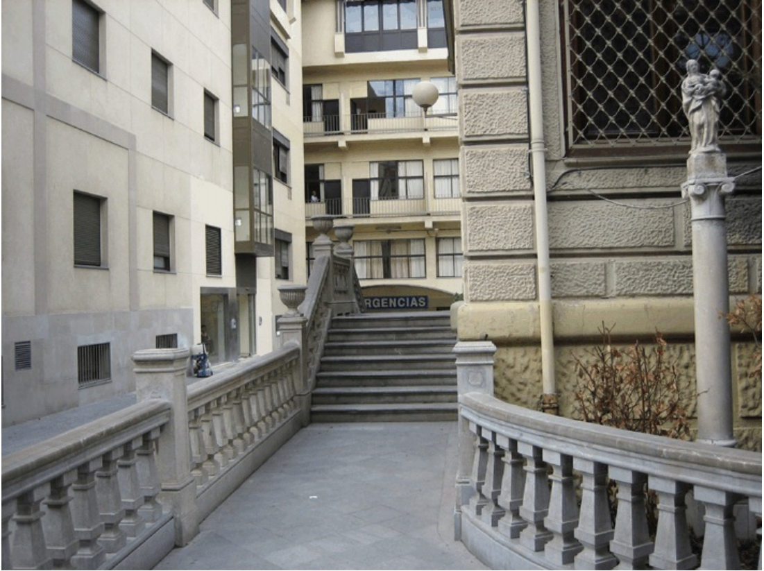
Foto en la que se pueden apreciar las diferentes fases constructivas del Hospital. (J. M. L. G.)
