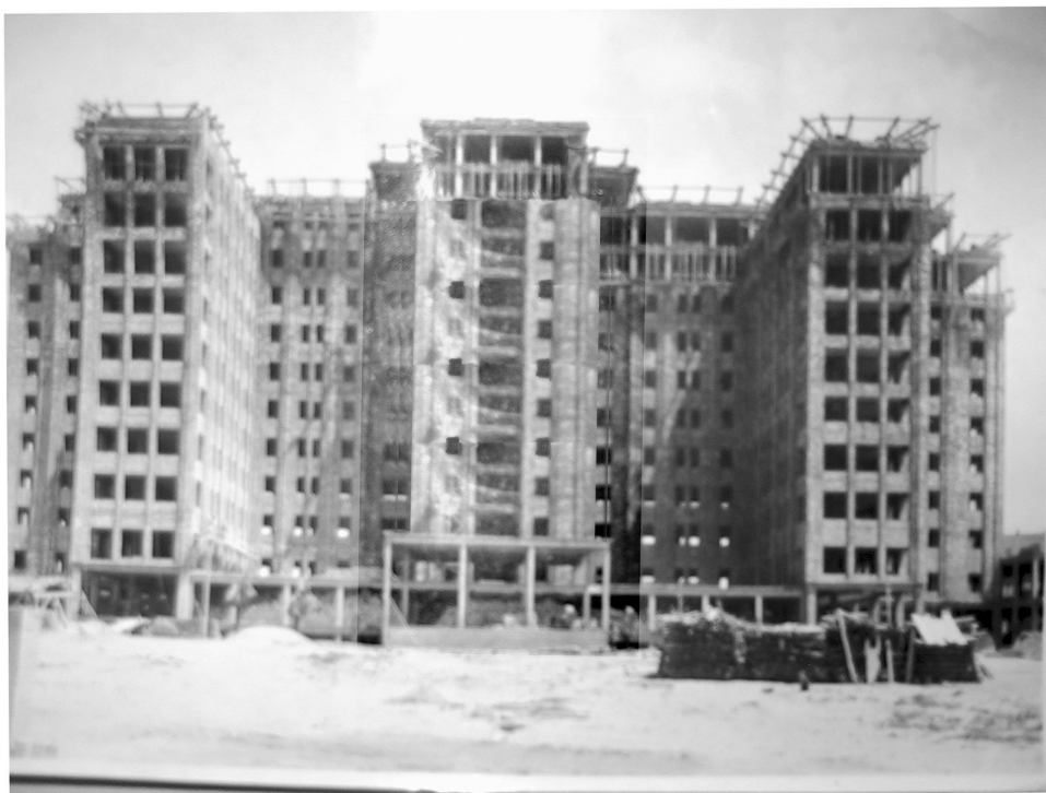
La Residencia Sanitaria Ruiz de Alda en obras. (A. R. V. B)
