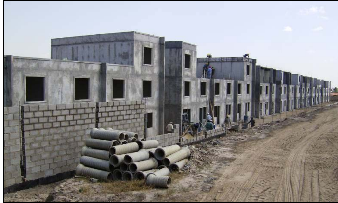
Fotografía 3.18: Vista de construcción de viviendas con sistema túnel Cabdare Estado Lara (Venezuela)
