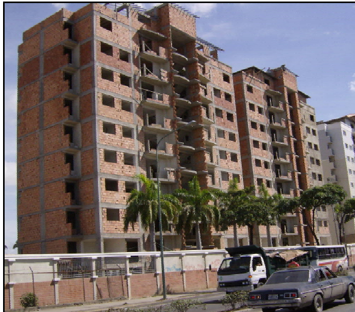
Fotografía 3.14: Vista de construcción de edificio residencial con sistema de pórticos en concreto (hormigón) armado Barquisimeto Estado Lara (Venezuela)
