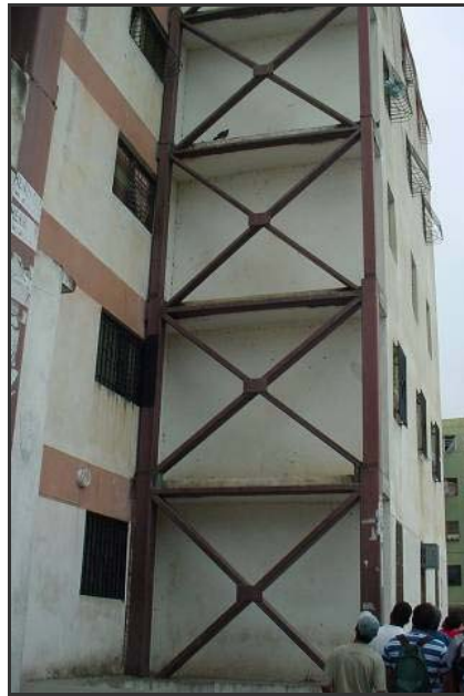
Fotografía 3.24: Vista de edificios residenciales reforzados por fallas detectadas luego de su ocupación Urbanización La Ruezga Barquisimeto Estado Lara (Venezuela)
