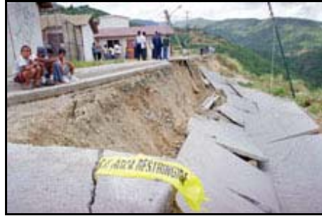
Fotografía 3.20: Vista de deslizamientos en Urbanización Nueva Tacagua Caracas (Venezuela)
