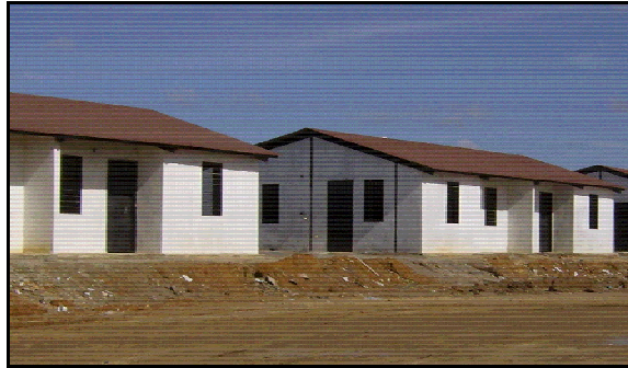
Fotografía 3.12: Vista de viviendas en urbanización popular Estado Lara (Venezuela)
