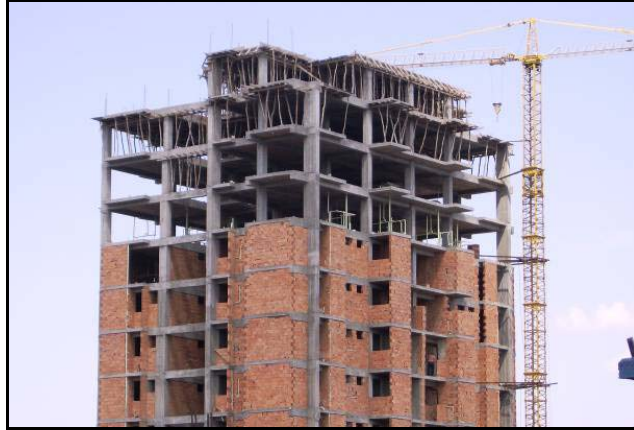
Fotografía 3.15: Vista de construcción de edificio residencial con sistema de pórticos en concreto (hormigón) armado Cabudare Estado Lara (Venezuela)
