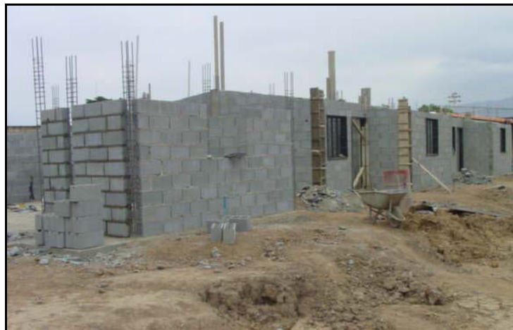
Fotografía 3.16: Vista de construcción de vivienda con sistema de mampostería confinada en el Estado Lara (Venezuela)
