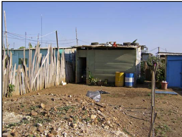
Fotografía 3.13: Vista de vivienda tipo inaceptable Estado Lara (Venezuela)
