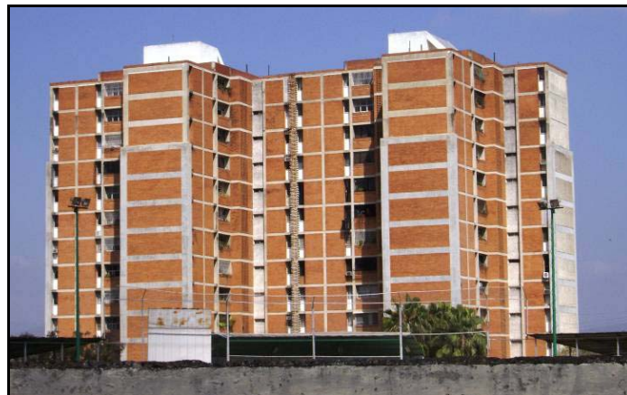
Fotografía 3.25: Vista de edificios residenciales reforzados por fallas detectadas luego de su ocupación Conjunto Doña Camila Cabudare Estado Lara (Venezuela)
