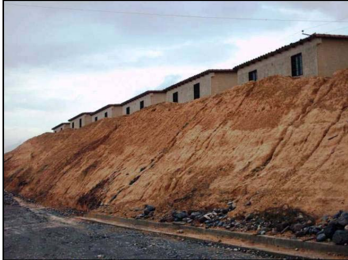
Fotografía 3.26: Vista de urbanismo con fallas por falta de protección en taludes Cabudare Estado Lara (Venezuela)
