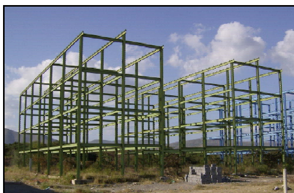
Fotografía 3.23: Vista de edificios residenciales inconclusos por fallas en el sistema estructural Sector Los Crepúsculos Barquisimeto Estado Lara (Venezuela)
