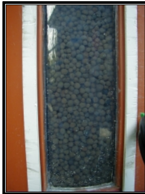
Figura 6.6.- Vista interior lecho inundado. Ventana metacrilato.
