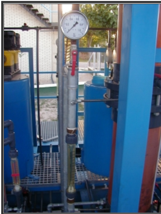
Figura 6.14.- Detalle de rotámetro y manómetro de aire de proceso
