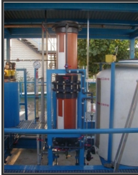
Figura 6.5.- Vista general lecho inundado.
