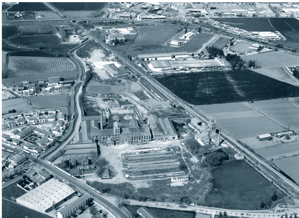
Fig. 6. Vista aérea del complejo industrial de S. Isidro
