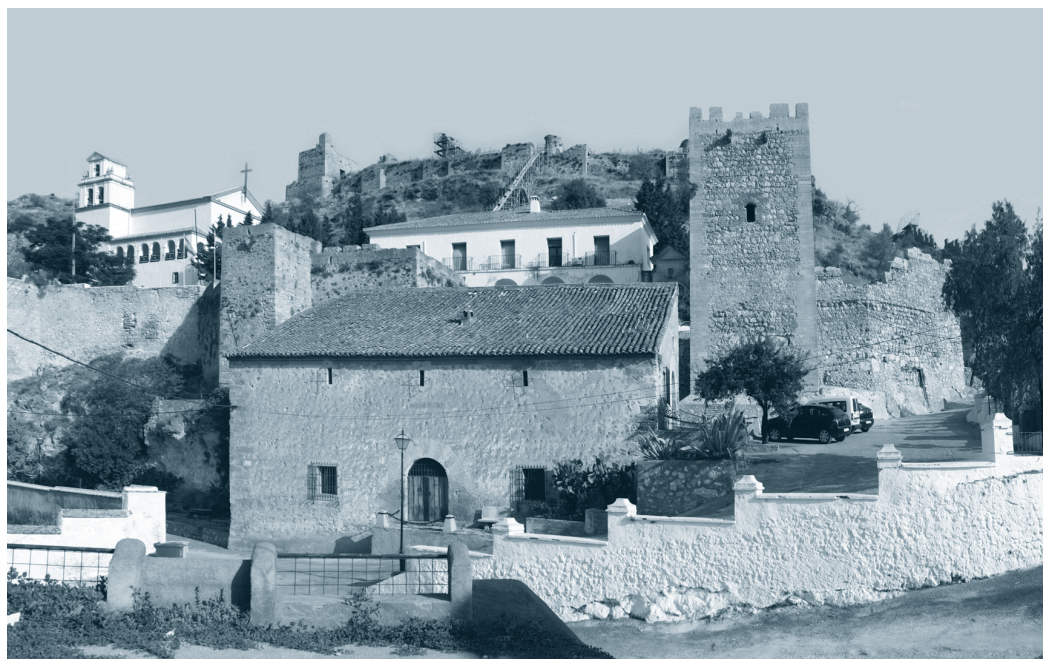
Fig. 6. Edificio del Pósito al pie de la Torrepuerta del Castillo
