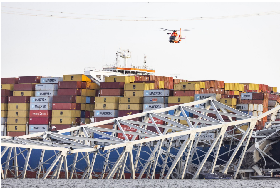
Figura 2: Contenedores en el buque MV Dali.
