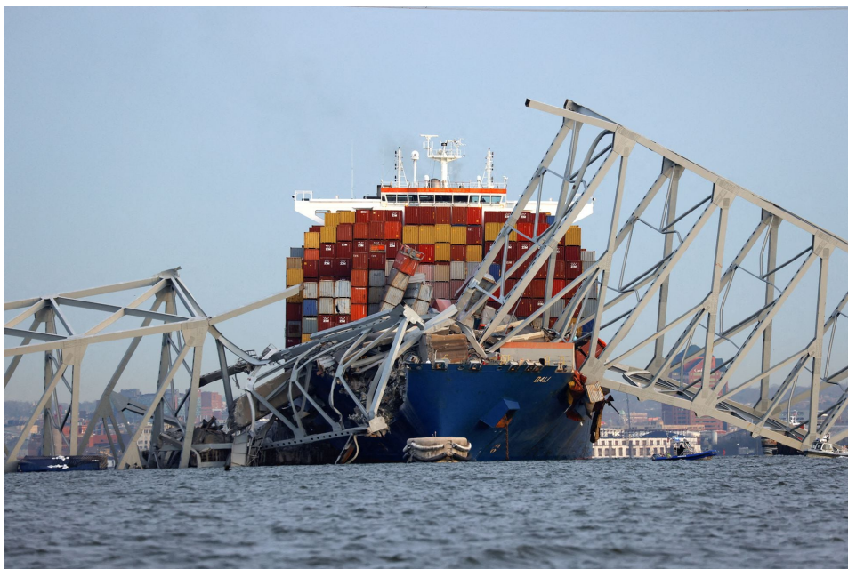
Figura 1: Colisión del buque porta-contenedores MV Dali con el puente Francis Scott Key en Baltimore (Río Patapsco, Maryland, Estados Unidos).
