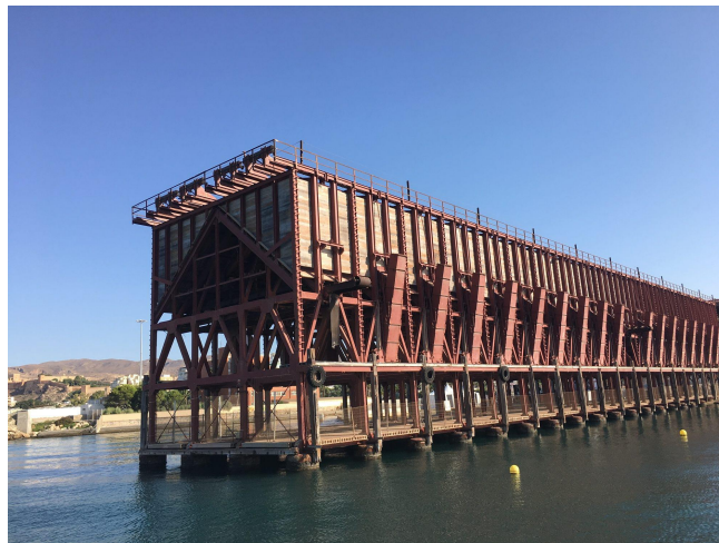
Figura 1: Cargadero de mineral, Puerto de Almería.
