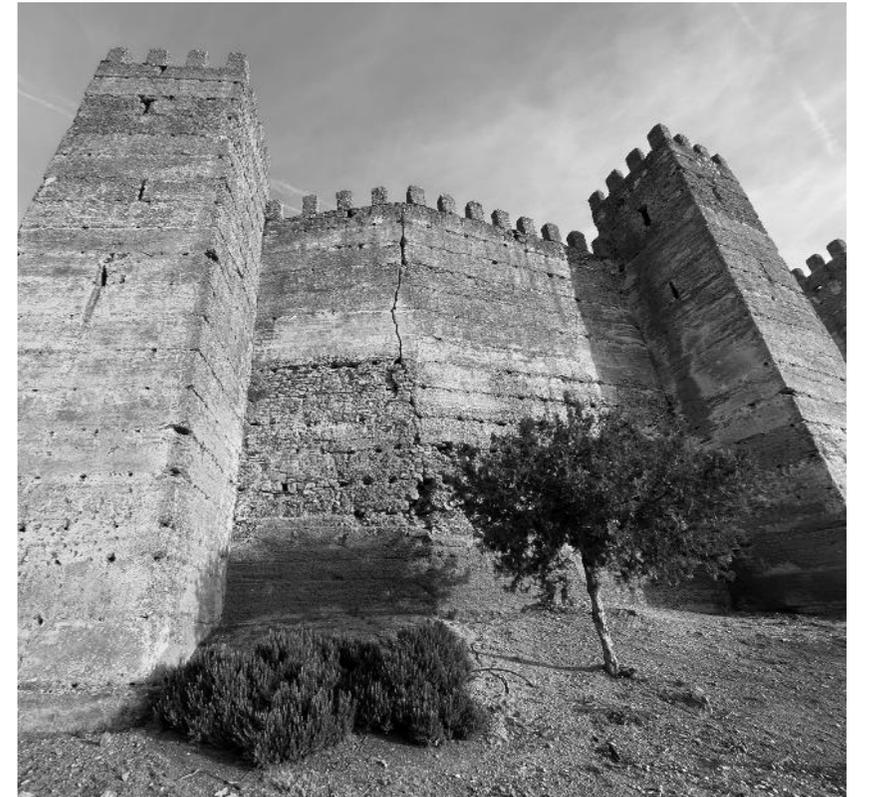
*Fotografía 60: Patologías del castillo, por las que se realizó la excavación de 2007, elaboración propia.*
