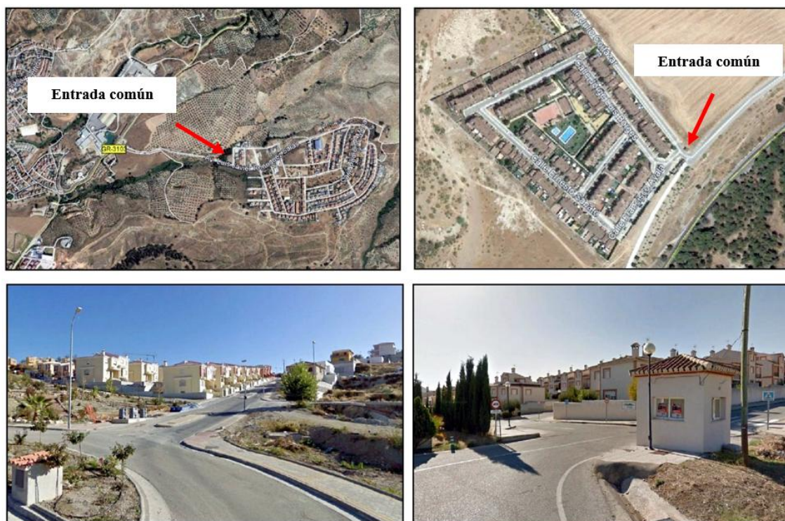
Figura 5.7. Complejos estructuralmente autoaislados: Jun (izquierda); Atarfe (derecha)
