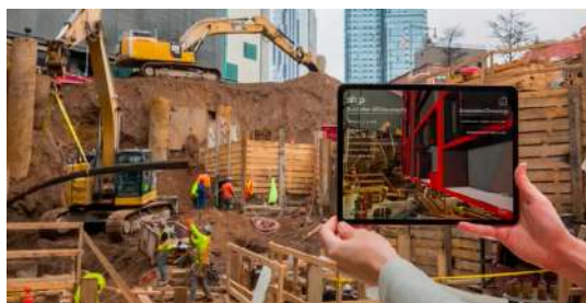
Figura 4. Superposición sobre el soporte de la realidad de un edificio en construcción de la estructura proyectada mediante realidad aumentada. Congreso AWE USA 2022, Enterprise - AR in Architecture - From Design to Construction . Fuente: https://www.youtube.com .
