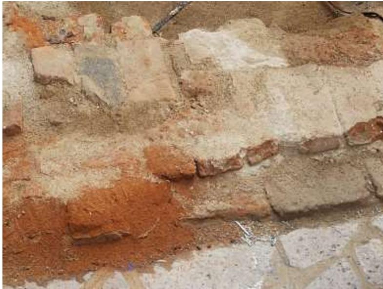
Figura 5. Cabecera deteriorada de estructura adjunta al canal 9 del antiguo estanque de agua virreinal del centro histórico de Trujillo.
