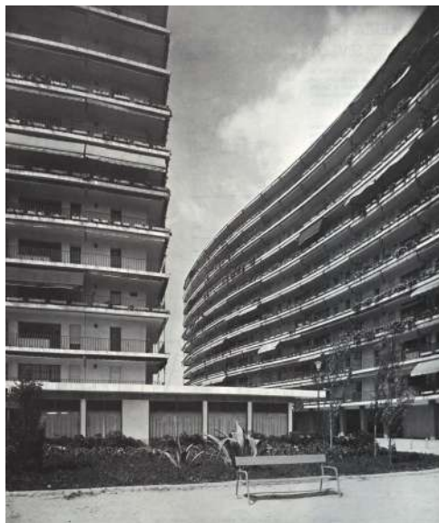
Figura 6. Vista de dos bloques. José Ramón Azpiazu Ordóñez, Luis Cervera Miralles, “Núcleo residencial en la Huerta de San Benito, Sevilla”, Arquitectura , n.º 194-195 (1975): 89-90.
