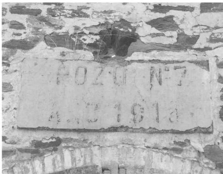
Figura 13. Casa de Máquinas Pozo nº 7.
