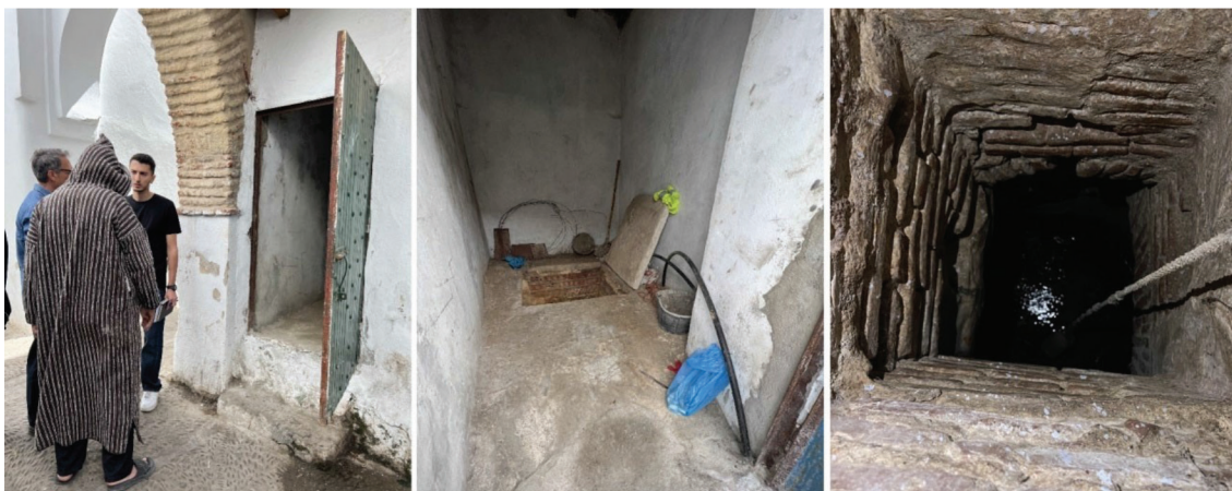
Figura 5. Depósitos de almacenamiento de la red Skundo de la medina de Tetuán, estado actual. Izda: exterior depósito de almacenamiento. Centro: vista interior, al fondo la arqueta del depósito abierta. Dcha: pozo a depósito de almacenamiento
