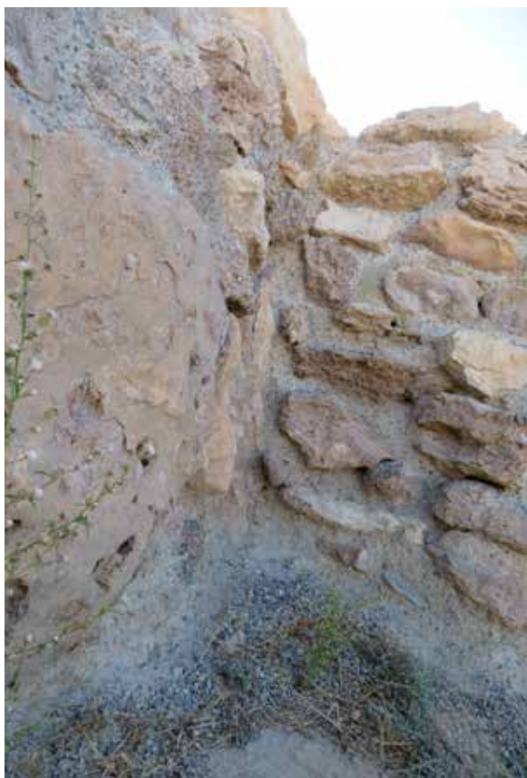
Fig.53. Detalle encuentro muro torre con muralla I
