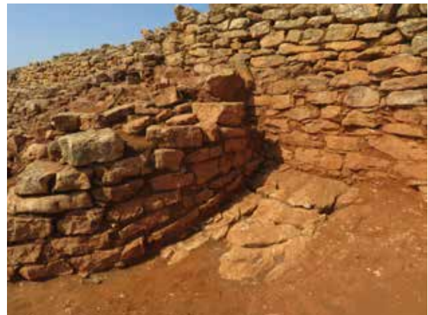
Fig.10. Adaptación hiladas mampuestos para nivelación en torre
