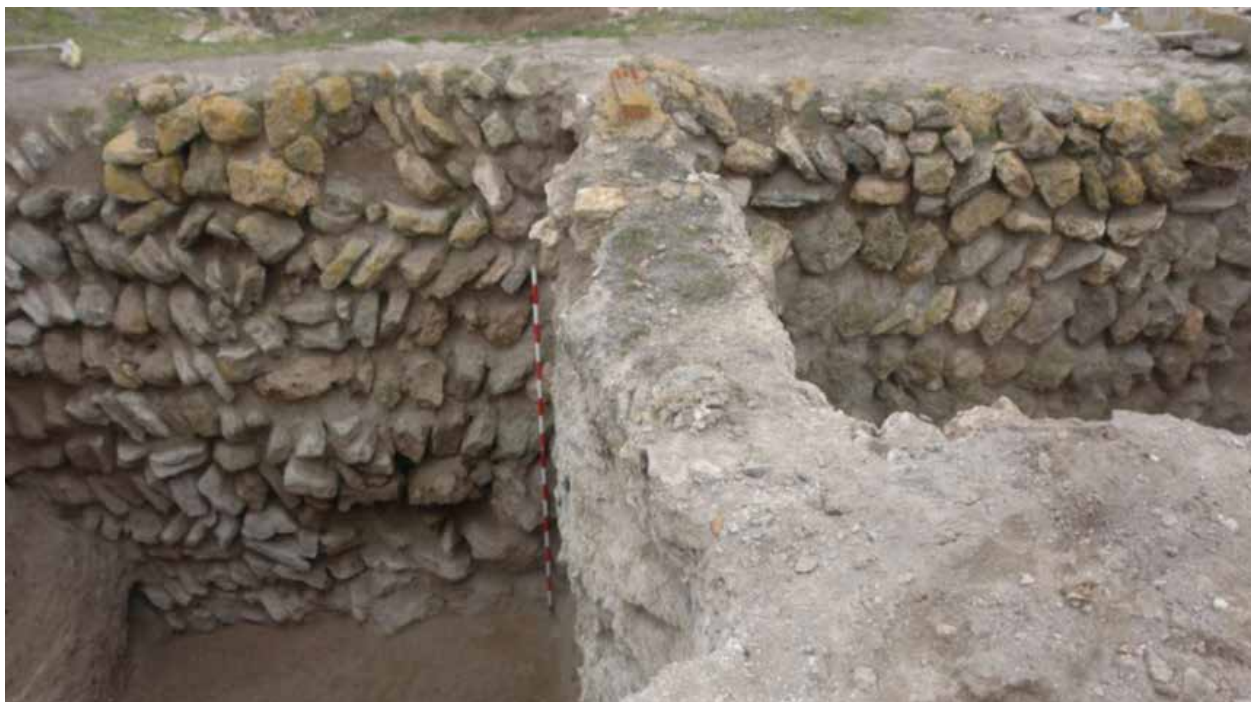
Fig.75. Detalle del aparejo de muro a sardinel
