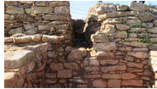
Fig.6b. Pasillo de acceso a torre
