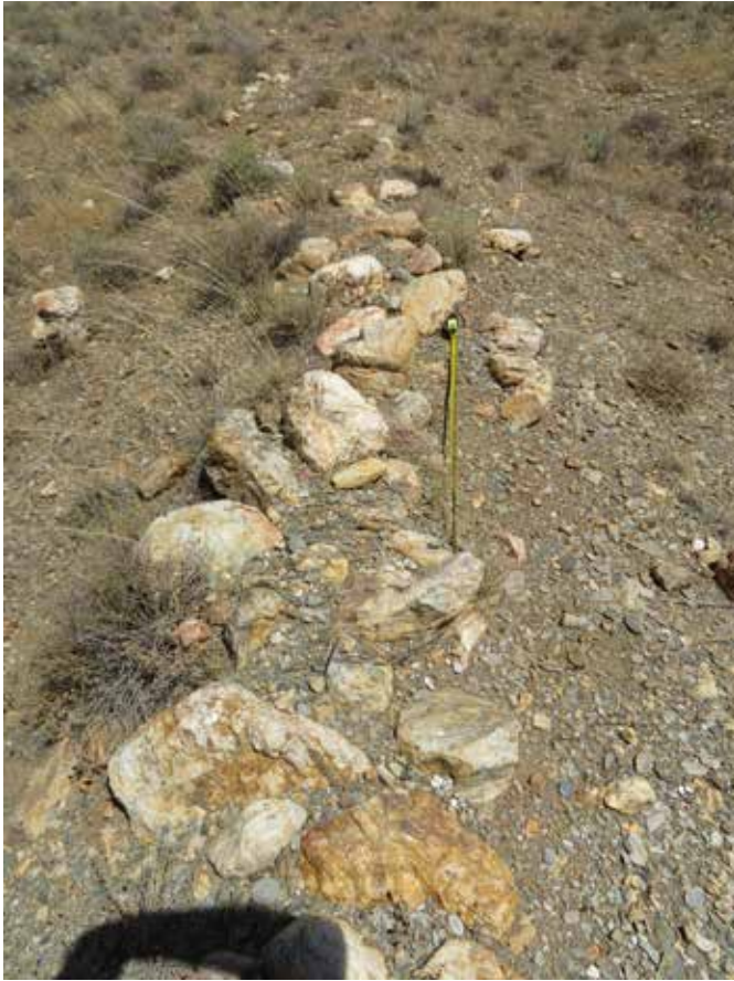
Fig.98. Detalle muro de cierre
