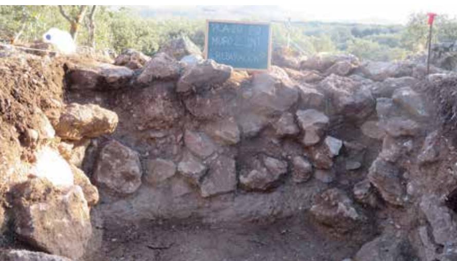
Fig.30. Detalle asiento lienzo interno muralla 2
