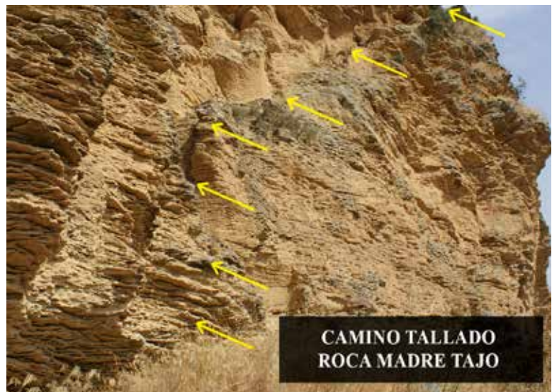
Fig. 1a. Acceso tallado en la roca
