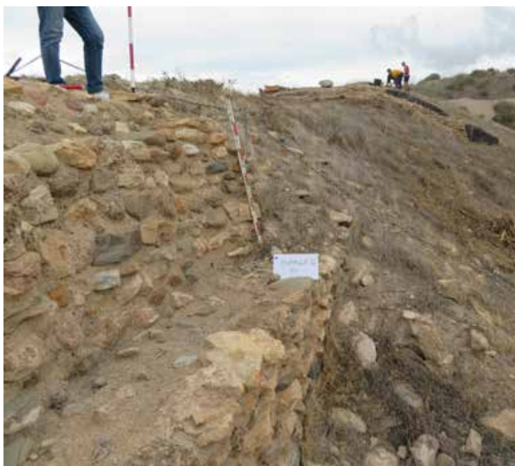
Fig.47. Detalle muro de refuerzo en la muralla IV
