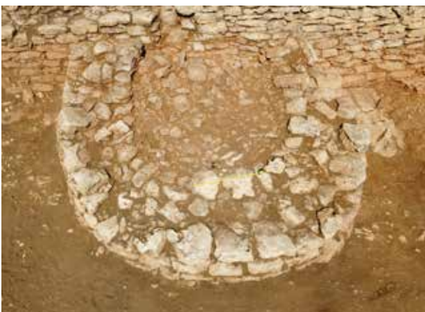
Fig.11. Detalle mampuestos adovelados
