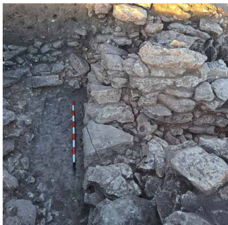
Fig.13a-13b. Detalle grieta del nuevo lienzo adosado a la muralla
