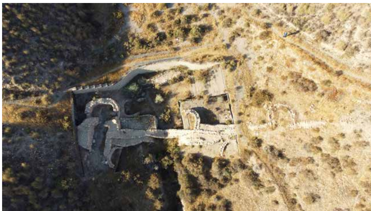
Fig.44. Vista cenital sector sur de la muralla I
