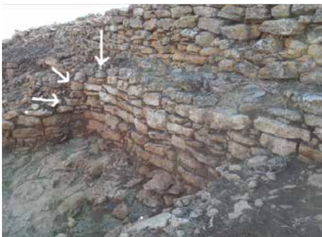
Fig.9a. Detalle de la traba contrafuerte-plataforma
