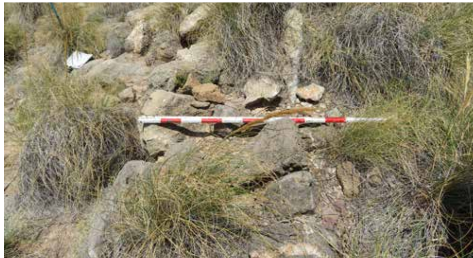
Fig.133. Detalle muro interior poblado
