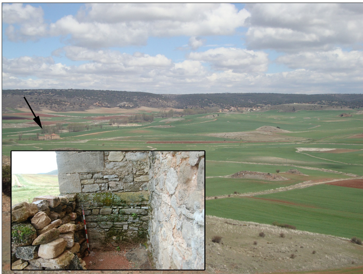
Fig. 6. La flecha indica la localización de la Ermita de los Quintanares en el Alto Henares (al fondo a la derecha queda el pueblo de Horna donde nace el río). En primer plano un detalle de la técnica constructiva que presentan los cimientos de uno de los muros del edificio
