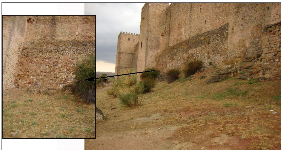
Fig. 11. Detalle de uno de los muros en la cara oeste del castillo, tradicionalmente atribuido a época andalusí
