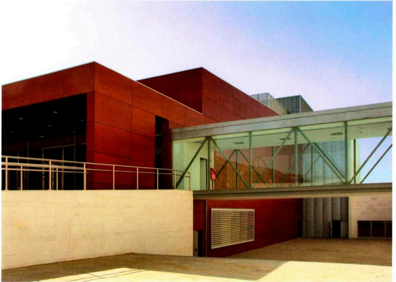
Pasarela de conexión del auditorio con el cuerpo de aulas, ejecutada con cercha metálica y paramentos acristalados.
