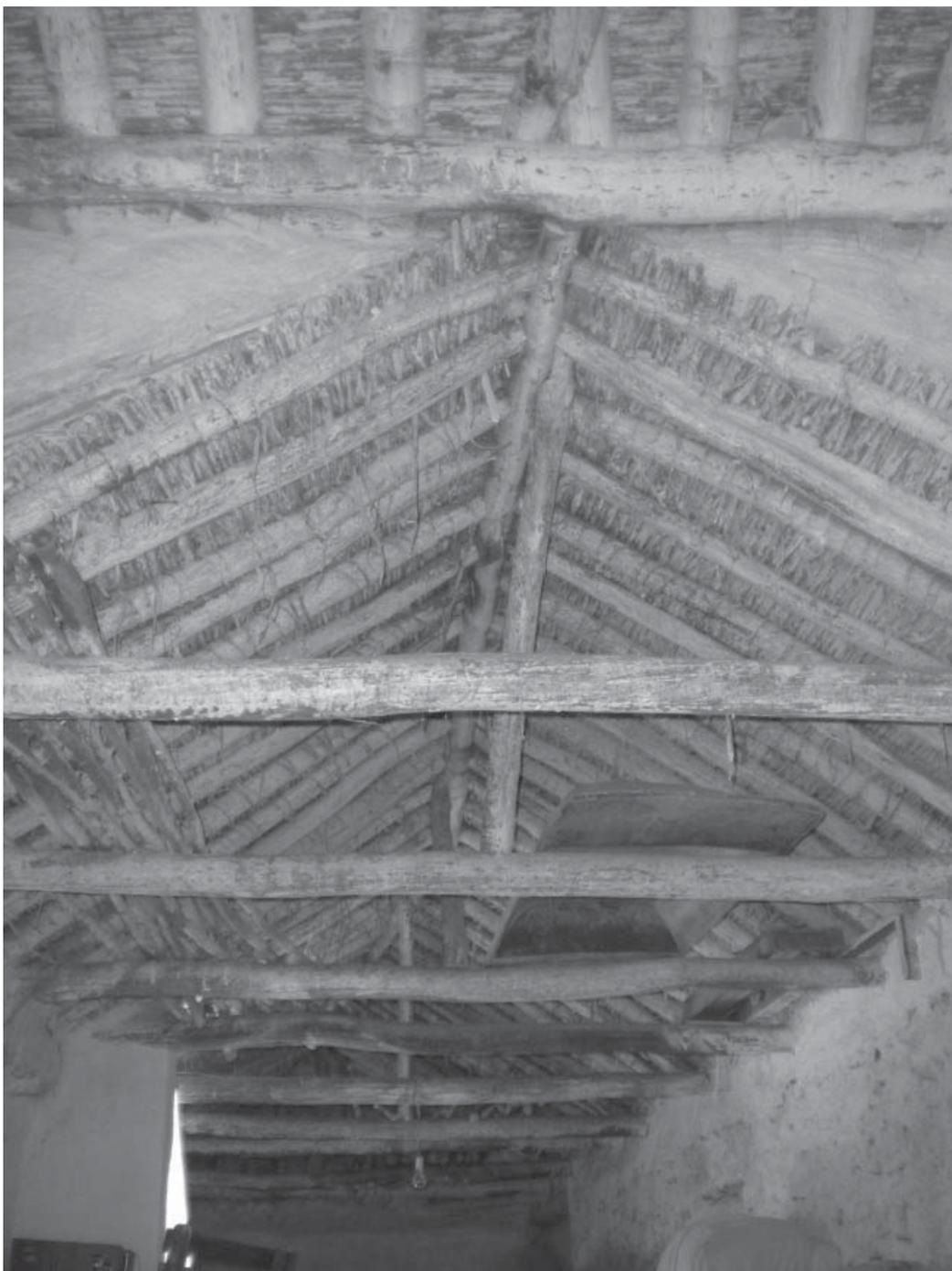
Fig. 4. Vista de la cubierta del granero de la Casa Figueroa, Nigüelas. Fotografía de M<sup>a</sup> Aurora Molina Fajardo
