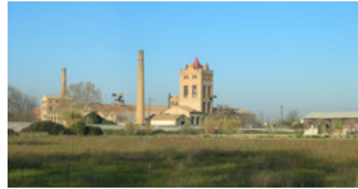
◊ Vista de la Azucarera de San Isidro con la torre alcoholera desde la Vega.
