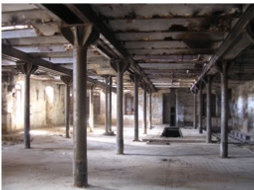
◊ Interior de la nave de turbinas con las columnas y capiteles de fundición.
