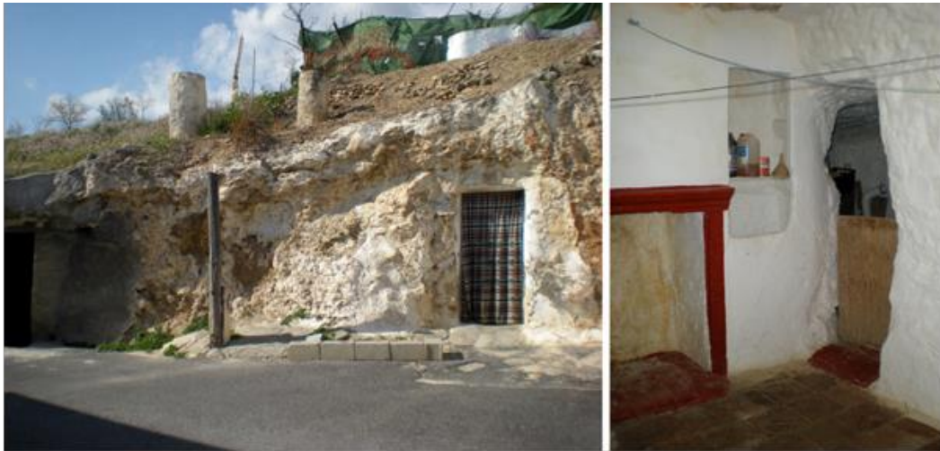
Figura 3. Fachada y vista interior de una casa cueva ubicada en la Calle Adrián López Iriarte de Padul. Fotografías de la autora, 2011.
