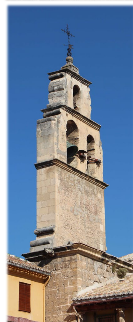
Figura 19.7. Espadaña de la Iglesia de Santo Domingo.
