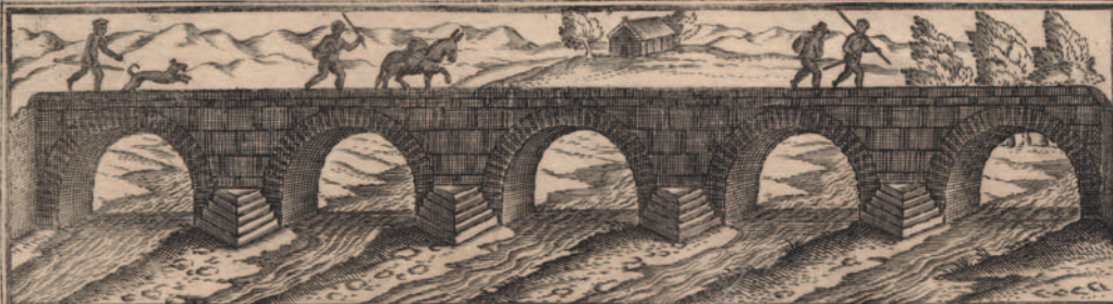
PUENTE DEL RIO GENIL
