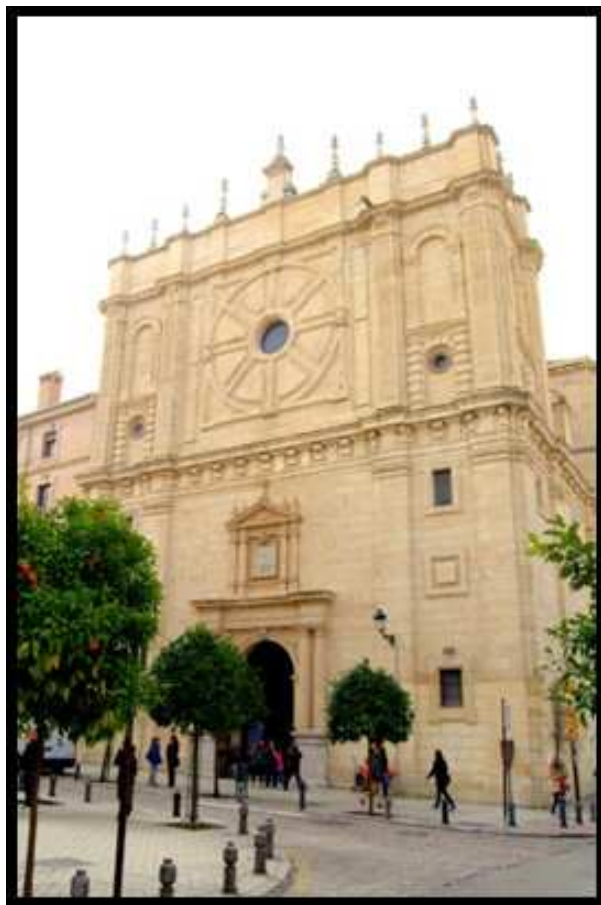
Fig. 3. Estado actual de la fachada principal del Oratorio.
