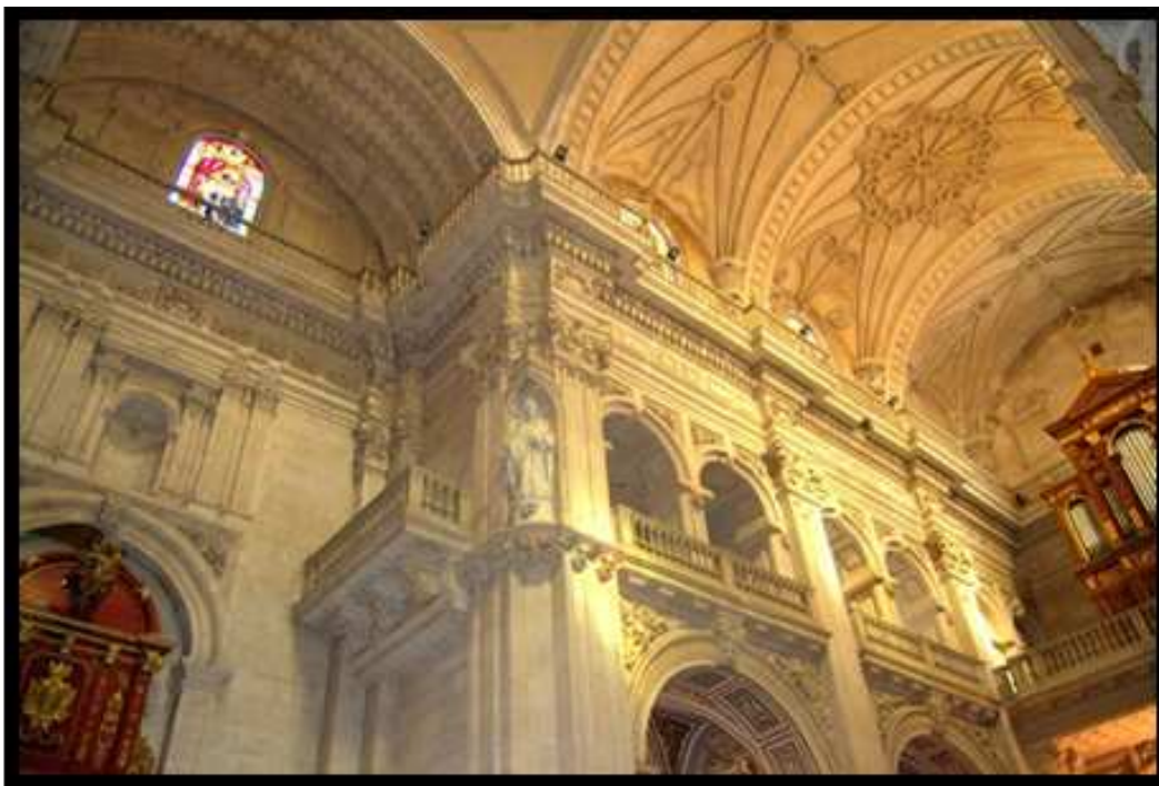
Fig. 4. Estado actual del interior del Oratorio.
