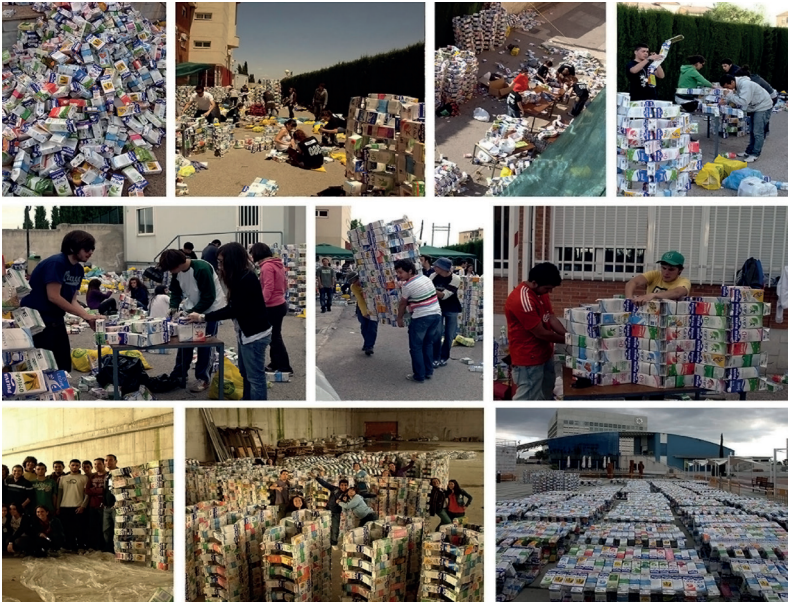
Figura 9. Proceso de premontaje en la ETSAG y traslado de los módulos al Parque de las Ciencias. CUAC Arquitectura (J Castellano + Tomás García) y SUGAR Platform. Fotógrafo: Javier Callejas
