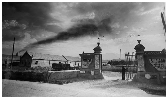
Solar y fábrica San Isidro
