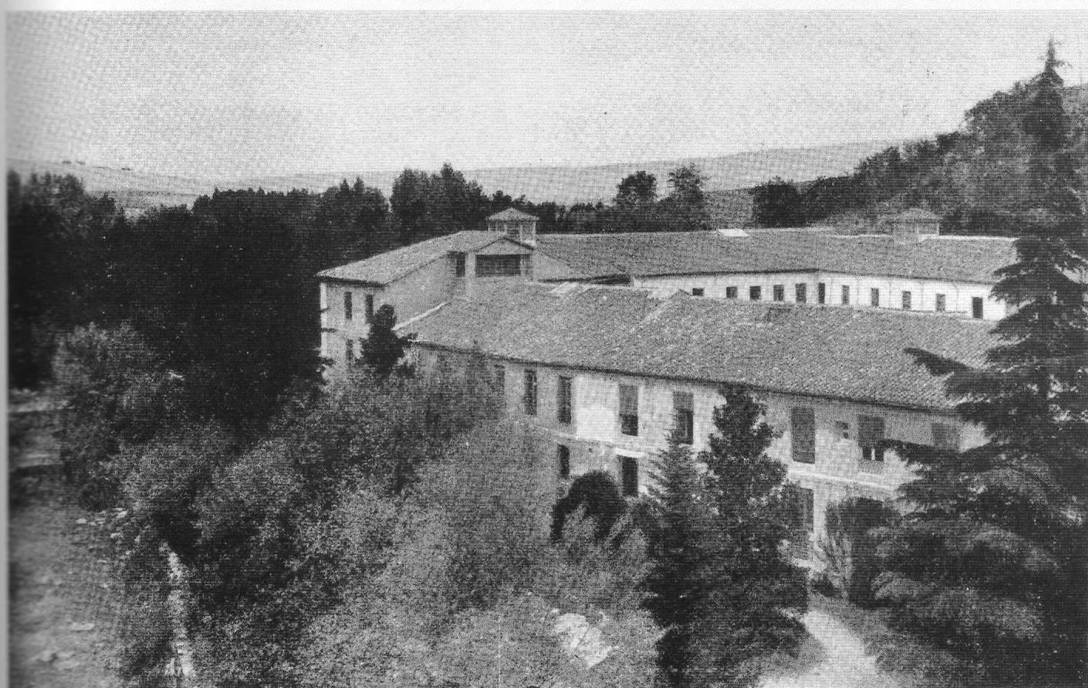
Pintoresca situación del establecimiento termal, cuyas aguas curativas gozan de universal renombre.
