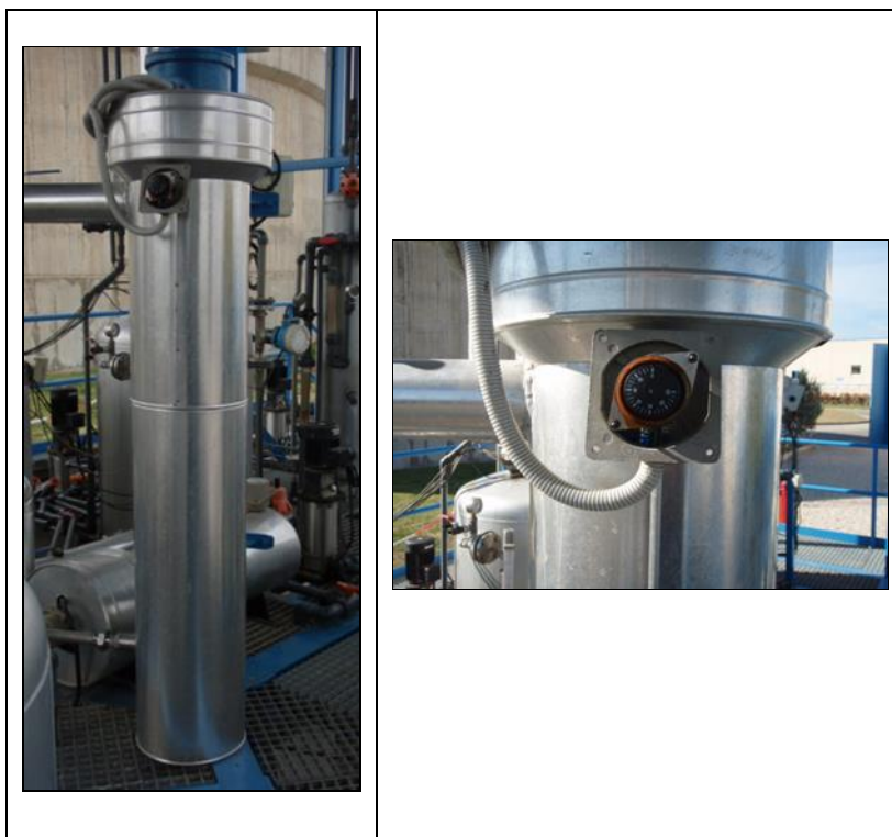
Figura 47: Calderín precalentador de amina.
