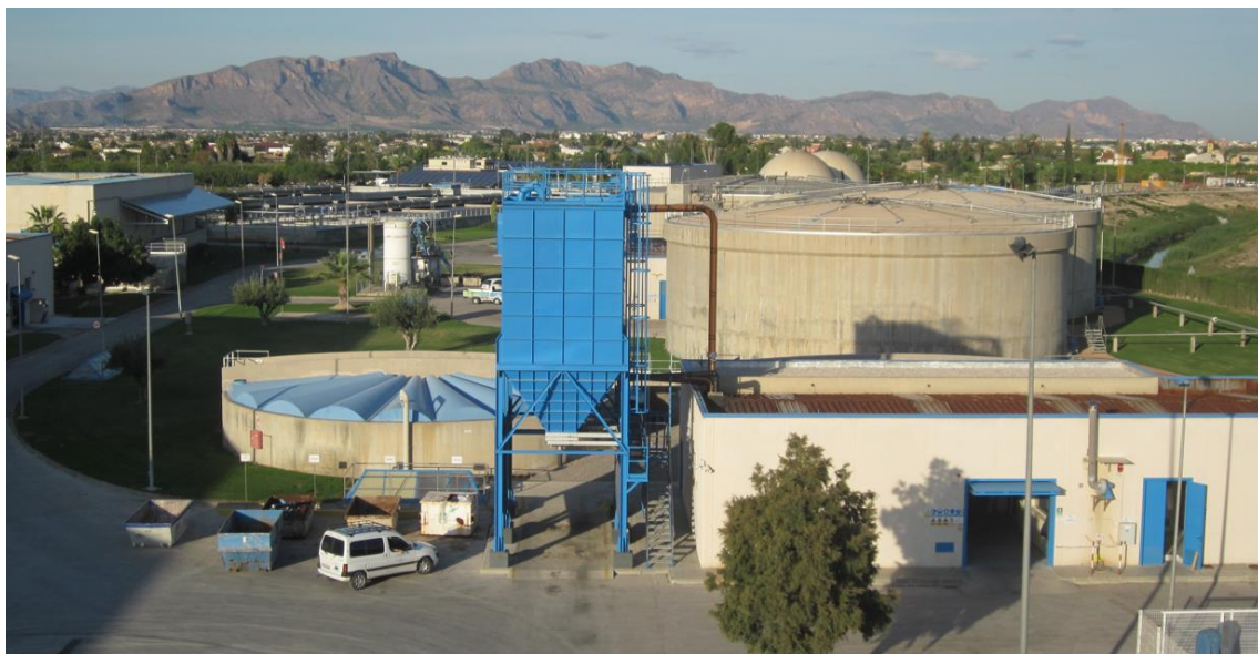
Figura 8: Digestor anaeróbico de la EDAR Murcia – Este.
