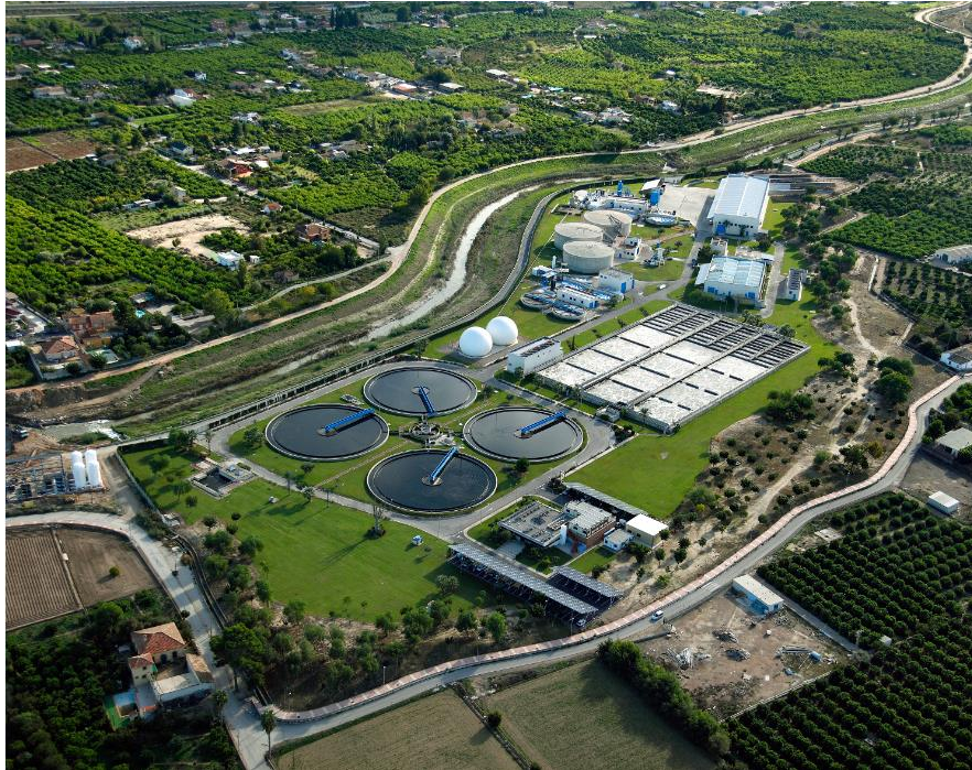
Figura 1: Vista general EDAR Murcia Este.
