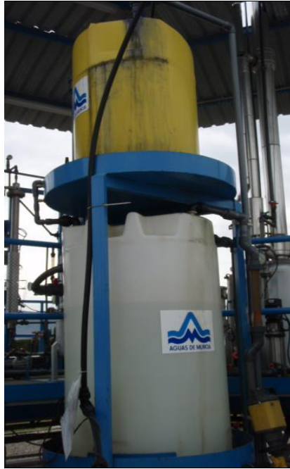
Figura 43: Depósitos de amina.
