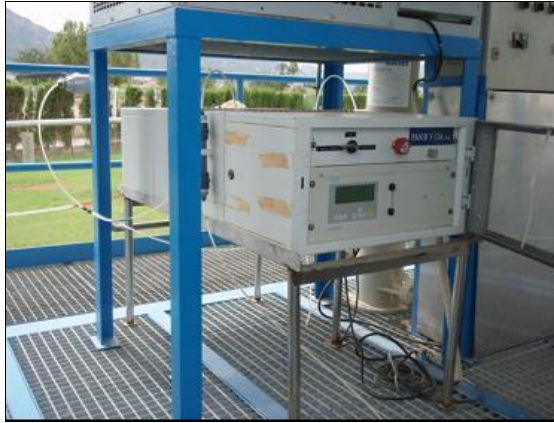
Figura 48: Imagen del equipo analizador en continuo Ultramat 23, instalado en la planta piloto.
