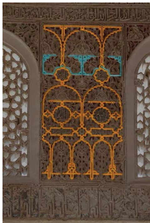
4. Trama decorativa completa del panel de yesería 6 del frente sur de la qubba.
