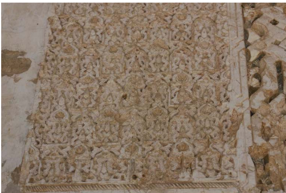
Ilustración 95: Detalle del frente de entrada a la qubba del Palacio del Partal Bajo. Fuente: fotografía de autor.
