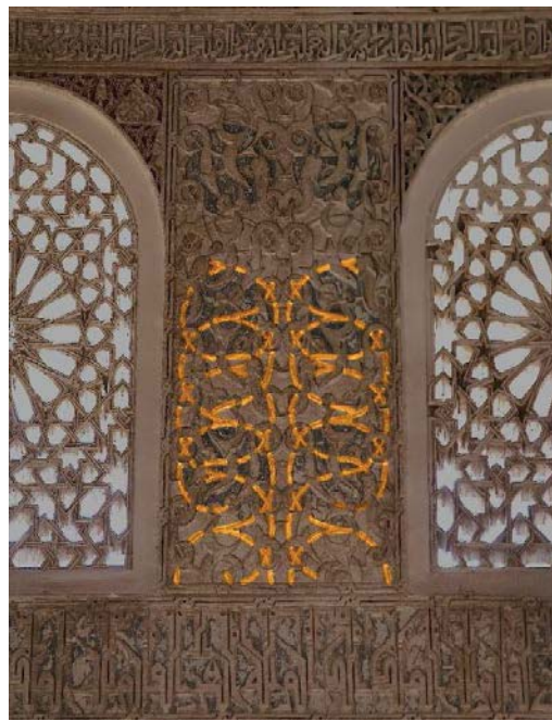
2. Trama 1 del panel de yesería.
