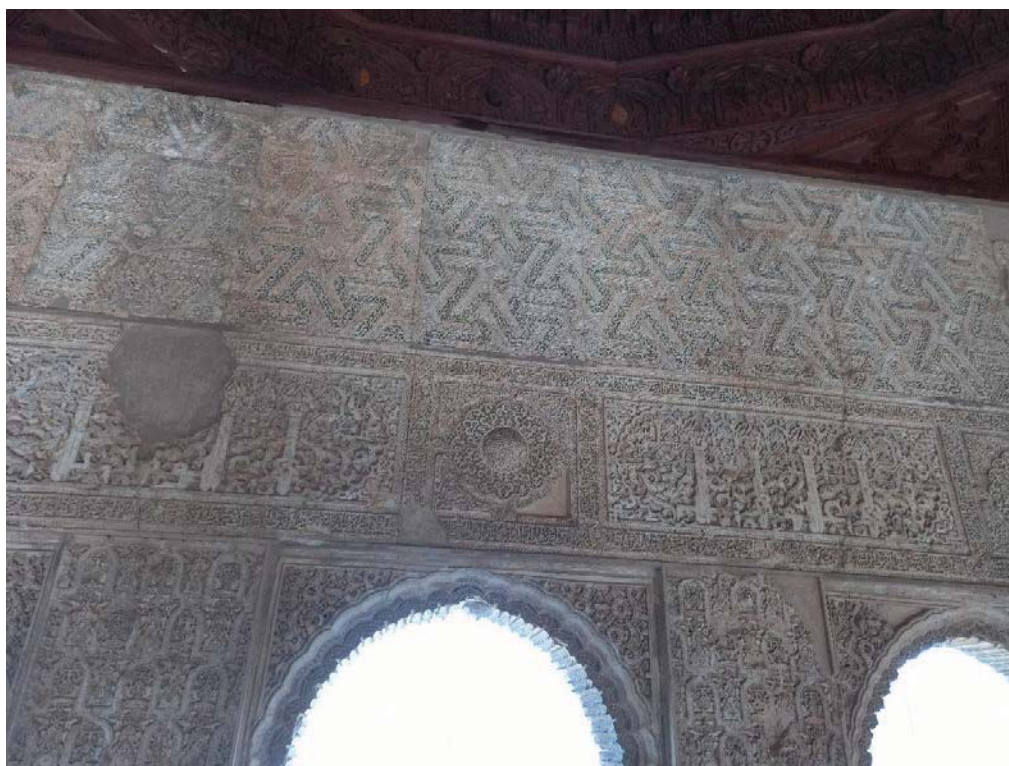
Ilustración 104: Detalle del interior de la Torre de las Damas del Palacio del Partal Bajo. Fuente: fotografía de autor.
