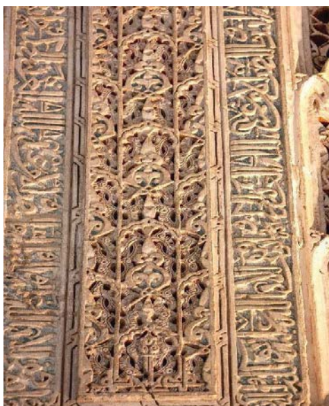
1. Detalle del panel de sebka del frente este de la qubba .
