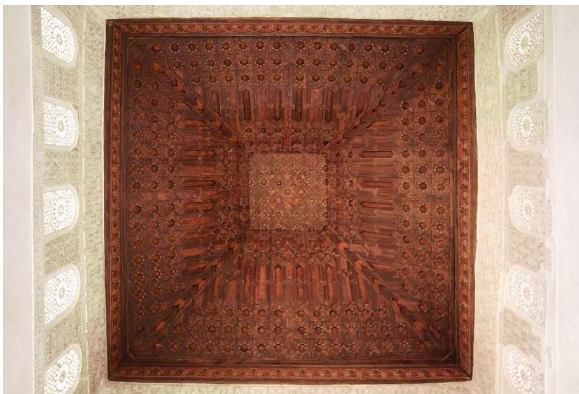
Ilustración 71: Armadura apeinazada de la qubba . Fuente: fotografía de autor.
