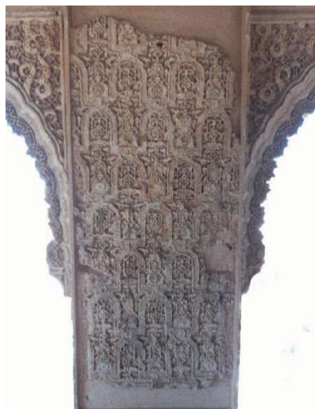
Ilustración 103: Detalle del interior de la Torre de las Damas del Palacio del Partal Bajo. Fuente: fotografía de autor.
