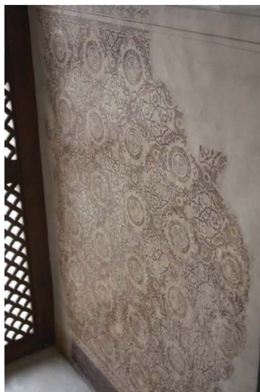
Ilustración 46: Zócalo estucado del interior del iwán oriental del frente sur de la qubba . Fuente: fotografía de autor.
