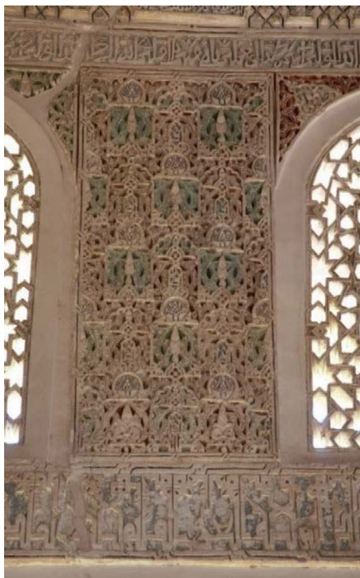
1. Vista del panel de yesería 8 del frente este de la qubba.
