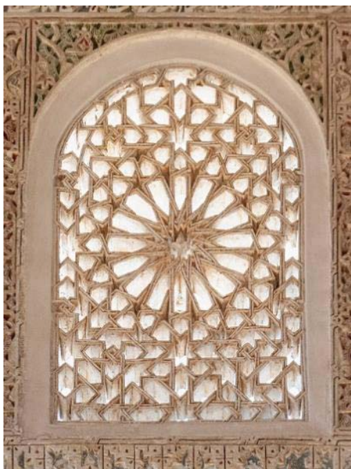
Ilustración 60: Celosía del cuerpo de ventanas del interior de la qubba . Fuente: fotografía de autor.
