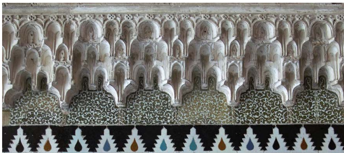
Ilustración 7: Detalle de la parte superior del zócalo y cornisa de mocárabes de la jamba izquierda del intradós del vano de acceso a la qubba . Fuente: fotografía de autor.
