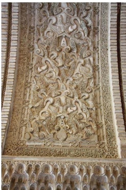
1. Detalle del intradós del vano de acceso a la qubba .
