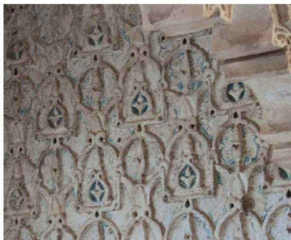
Ilustración 44: Detalle del panel de yesería del interior del iwan central del frente sur de la qubba . Fuente: fotografía de autor.
