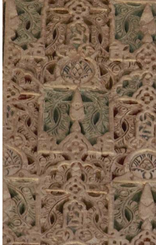
Ilustración 76: Detalle del panel de yesería del frente este del cuerpo de ventanas de la qubba Dār al-Manẓara al-Kubrā . Fuente: fotografía de autor.
