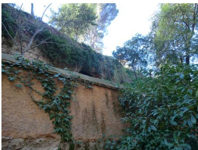
Ilustración 51. Parte de un silo nazari
