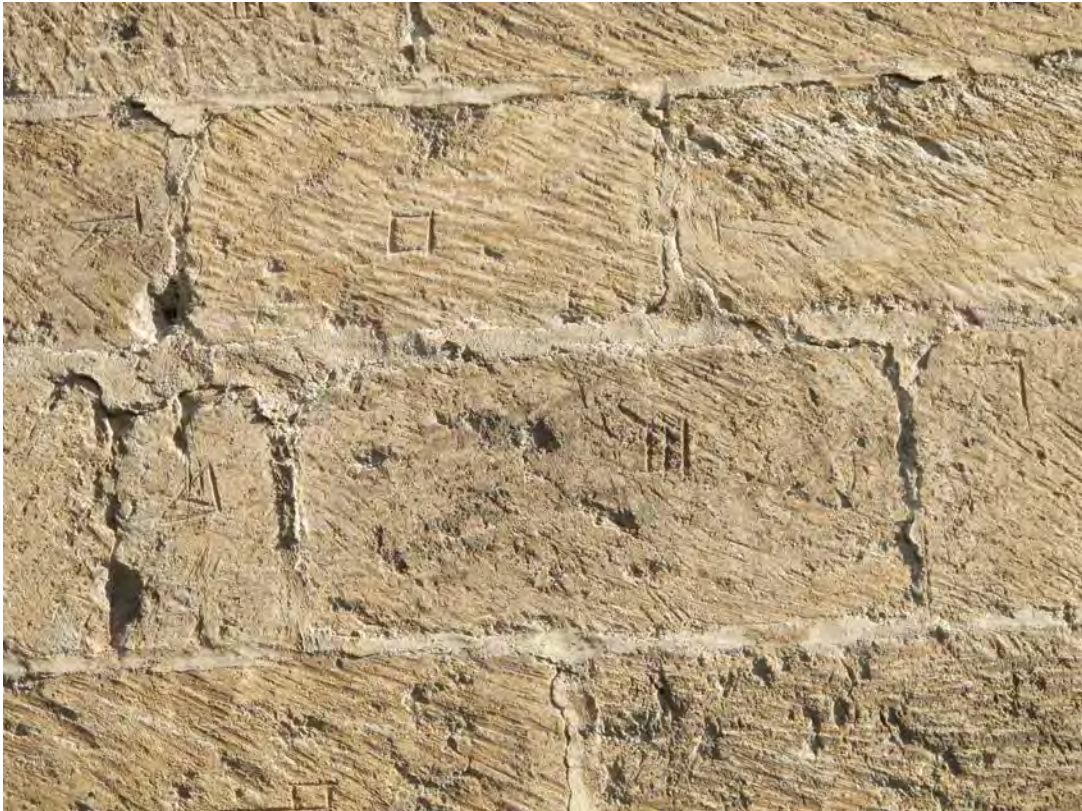
Fot.6 Sillares dispuestos a soga y tizón con diferentes marcas
