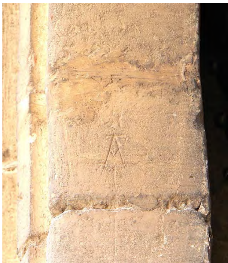
Fot.14 Marca de cantero de la portada de la Iglesia de Santa Isabel la Real
