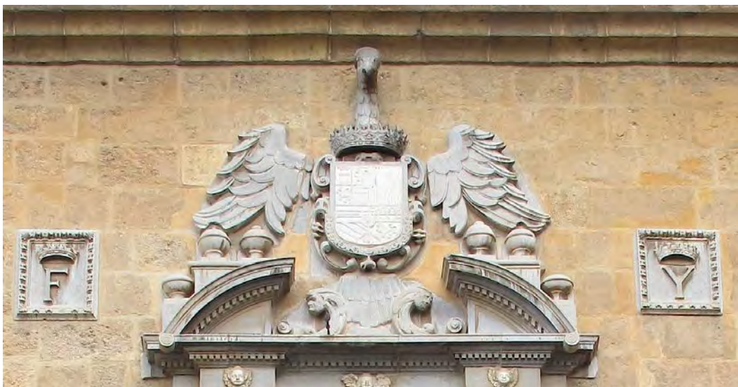
Fot.20 Iniciales F e Y de la portada principal
