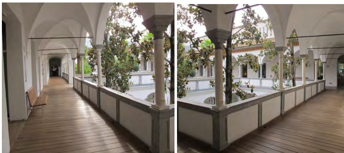
Fots.81-82 Galerías altas del primer y segundo patio
