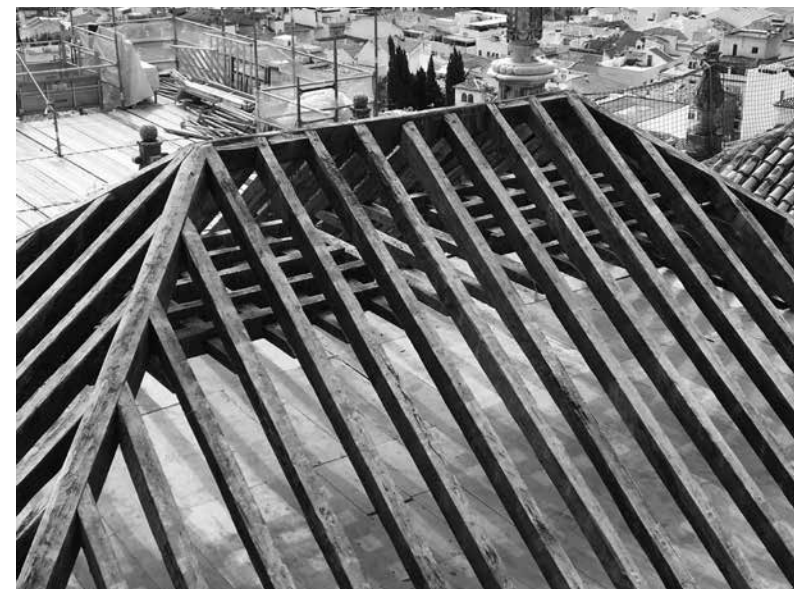
[Fig. 1] Armadura de par y nudillo. Pabellón 7. Catedral de Jaén. Garzón, Diego, 2021.
