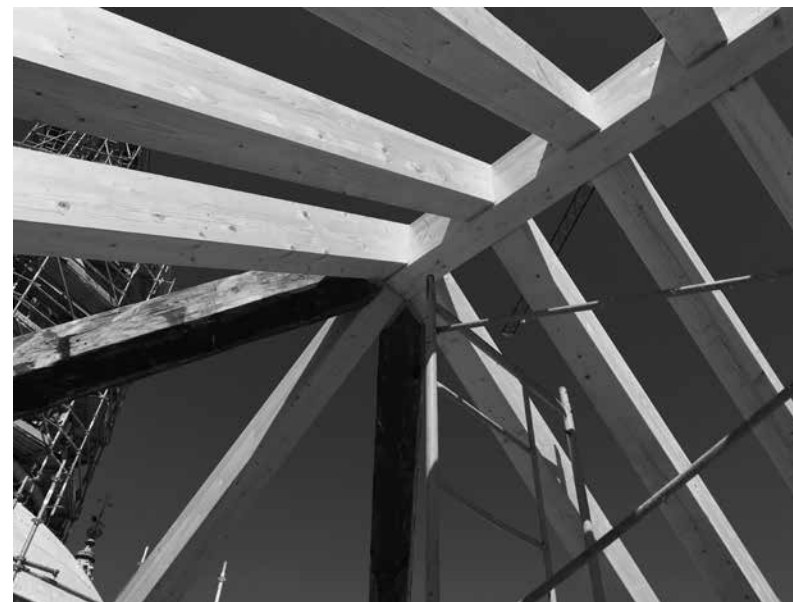
[Fig. 6] Encuentro de limas, par toral e hilera. Piezas nuevas en madera laminada. Catedral de Jaén. Garzón, Diego, Salmerón, Pedro, 2021.
