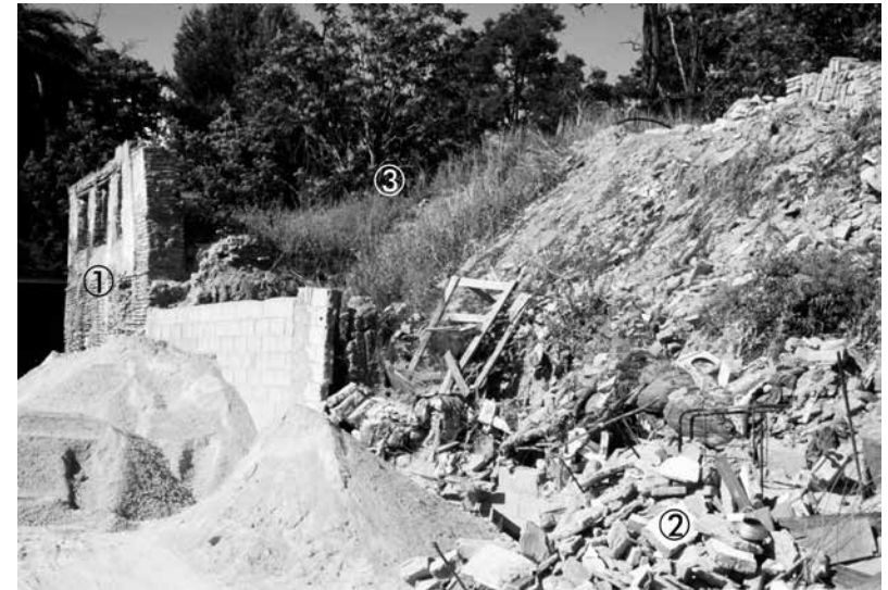
[Fig. 11] Leyenda: 1. Restos de fachada en pie de la casa de la Lona que actúan como contención de los escombros. 2. Escombros de la antigua corrala del siglo XVII derruida. 3. Jardín parásito sobre los escombros.
