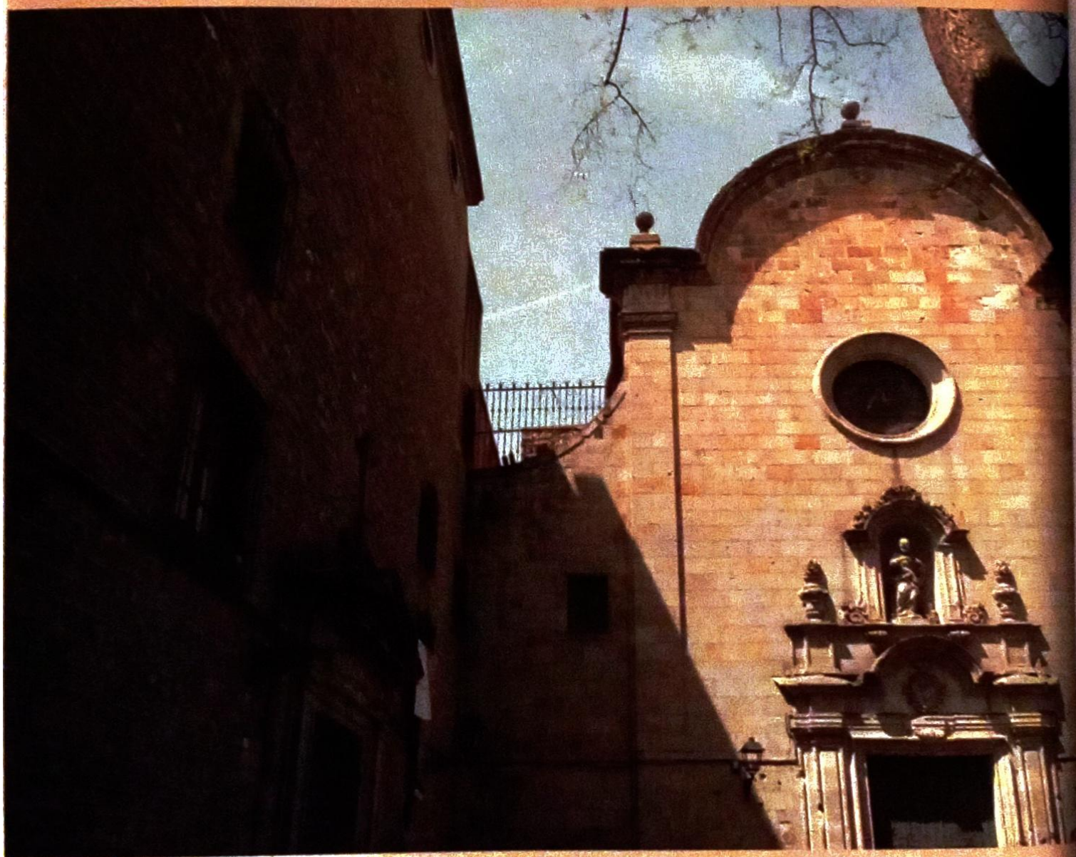
Fig. 6 Fachadas del Oratorio e iglesia de Barcelona. Estado actual
