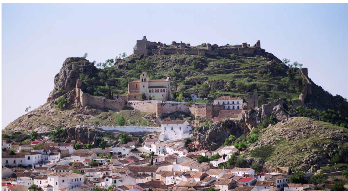
Imagen. 3.5.1: Vista general del castillo de Moclín y del núcleo actual. Fuente: García Porras (2014)
