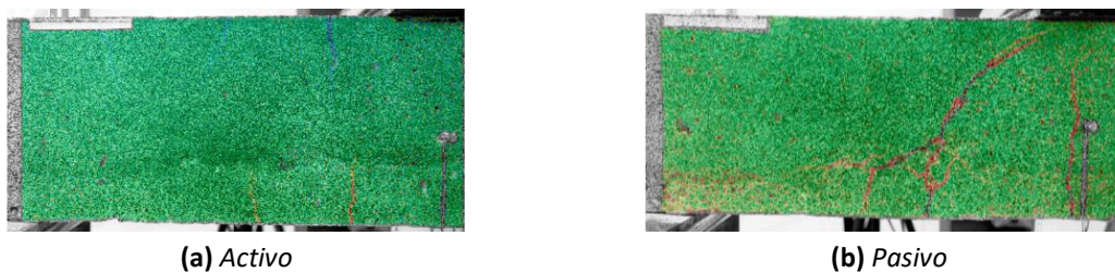
Figura 4. Patrón de fisuración en ELS ( V = 26.19 kN).
