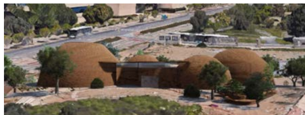
Figura 1. Conjunto arquitectónico sobre el que se encuentra la cúpula.
