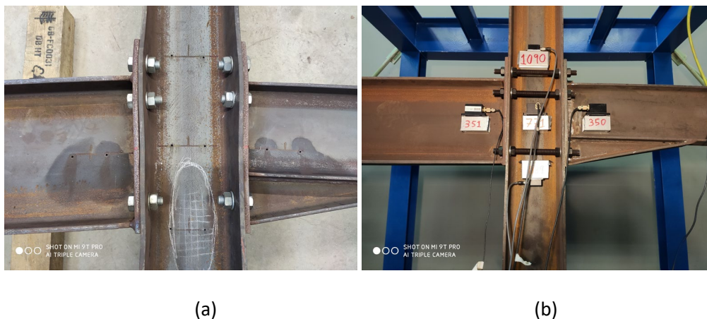
Figura 2. Vistas de detalle de los nudos tras los ensayos: (a) con tornillos simples y (b) con barras roscadas.
