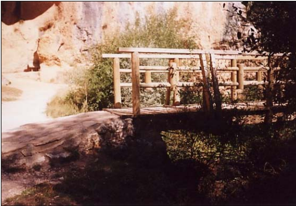
Fotografía 50. Puente sobre el río Lobos.
