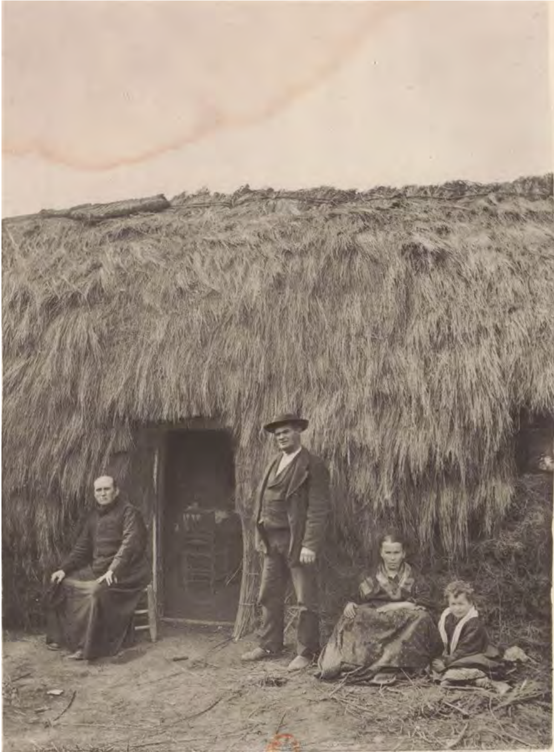
Residencia provisional del Alcalde de Játar.
