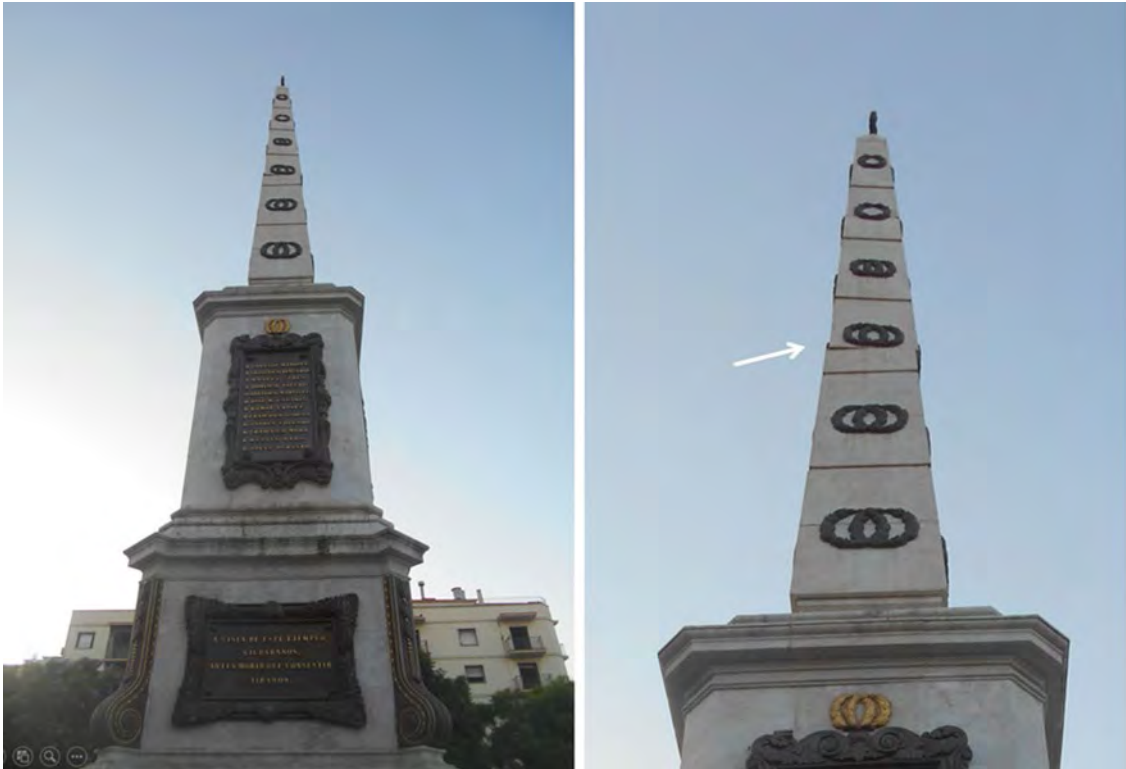
Detalles del monumento al general Torrijos levantado en la Plaza de la Merced (Málaga), indicando la flecha el giro inducido por el terremoto de 1884.
