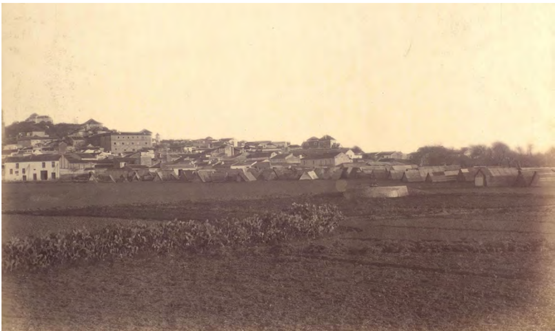
Campamento instalado en las afueras de Vélez Málaga tras el terremoto del 25 de diciembre de 1884. Panorámica de Etienne- Alfred Esperon y Tisne (1843-1900), fotógrafo de la Real Cámara, que acompañó al rey Alfonso XII cuando visitó la zona afectada por el sismo.
