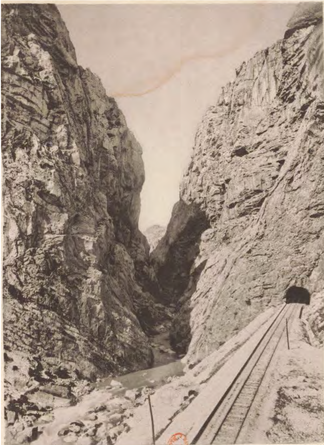
Túnel excavado en calizas titónicas entre Gobantes y el Chorro. Provincia de Málaga.
