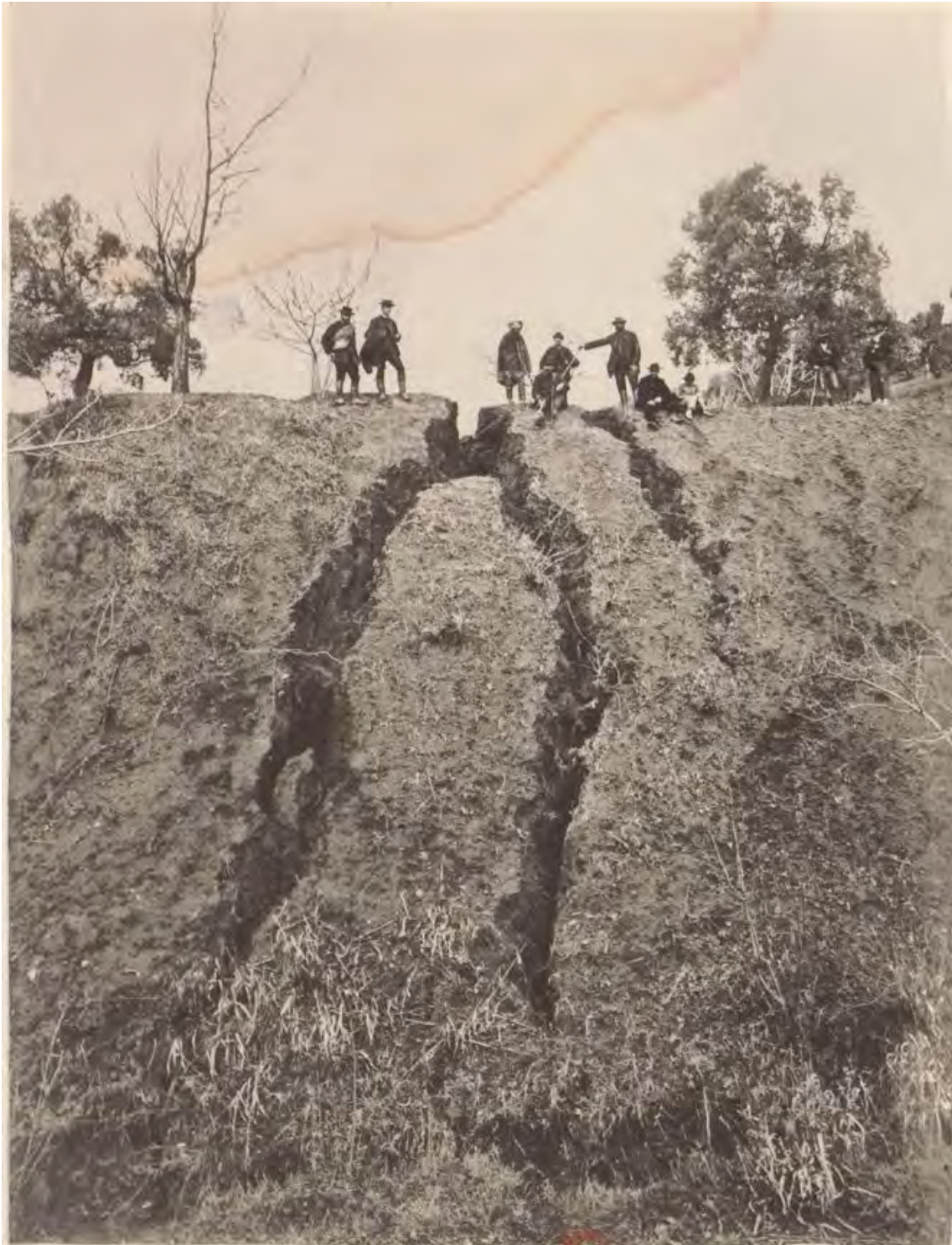
Las grietas de Güevéjar producidas por el terremoto.
