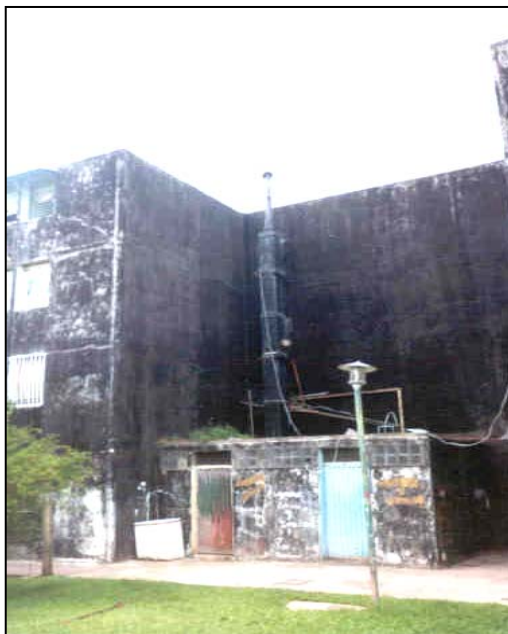
Fotografía N° 13: Vista General de una Edificación Antes de ser Rehabilitada
