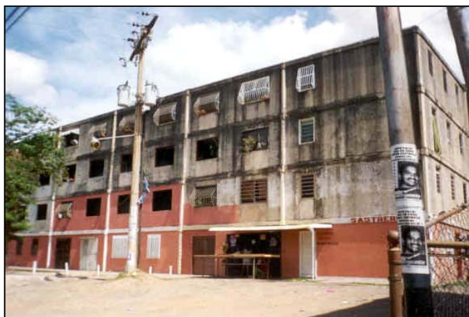
Fotografía N° 9: Vista de una Edificación Multifamiliar sujeta a Rehabilitación
