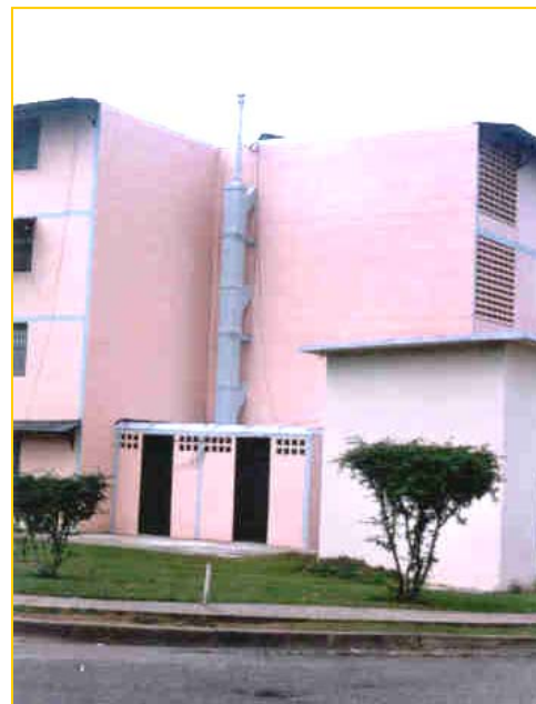
Fotografía N° 14: Vista General de una Edificación Después de ser Rehabilitada
