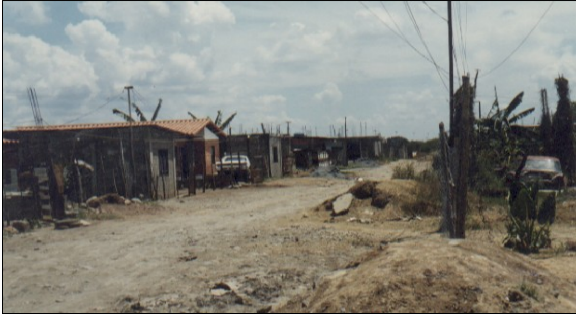
Fotografía N° 11: Construcción de Viviendas en Parcelas Aisladas, mediante Créditos Individuales
