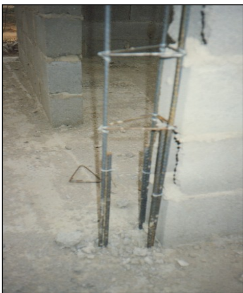
Fotografía N° 5: Construcción de Columnas
