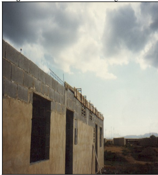
Fotografía N° 6 Construcción de Vigas
