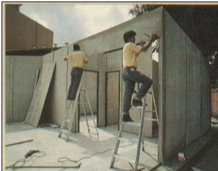
Fotografía N° 8: Ensamble de las Paredes en casas construidas con el Sistema S2
