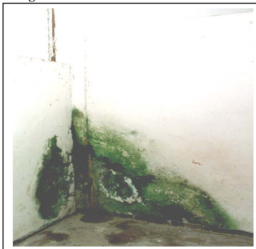
Fotografía N° 28: Moho en Paredes
