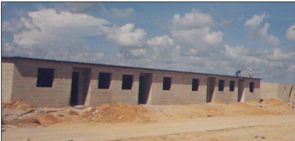
Fotografía N° 4: Urbanización de Viviendas Populares construidas con el Sistema Porticado de Concreto Armado
