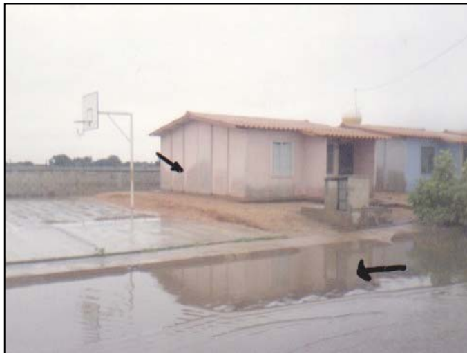
Fotografía N° 31: Problemas de Drenaje Urbano en la Vialidad interna de las Urbanizaciones estudiadas
