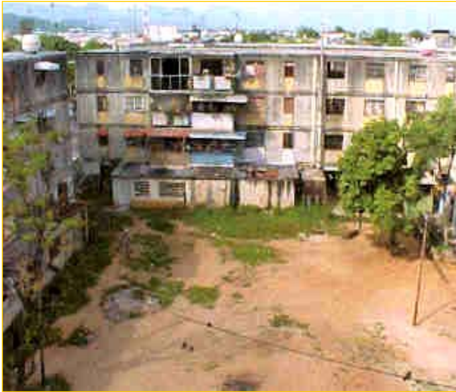
Fotografía N° 12: Vista General de una Edificación Multifamiliar sujeta a Rehabilitación
