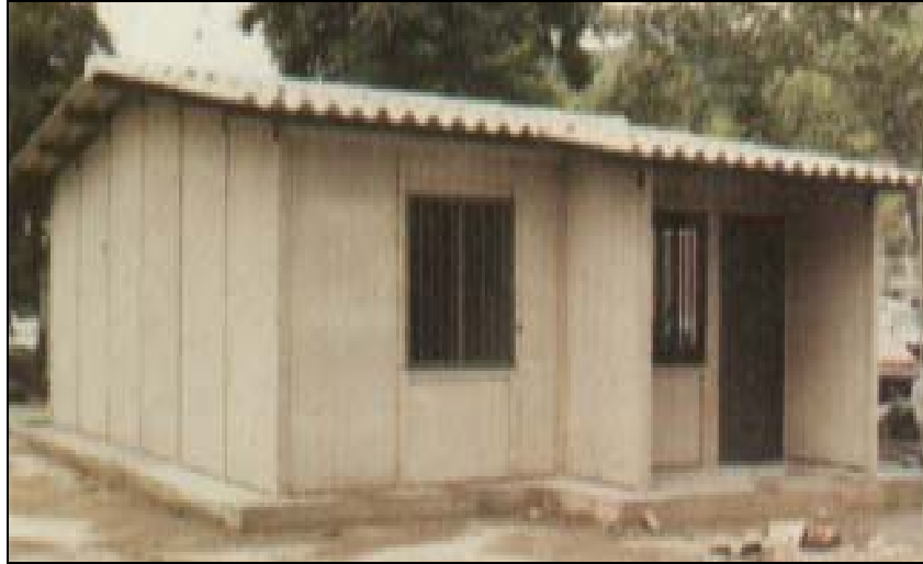
Fotografía N° 7: Vista de una casa construida con el Sistema S2
