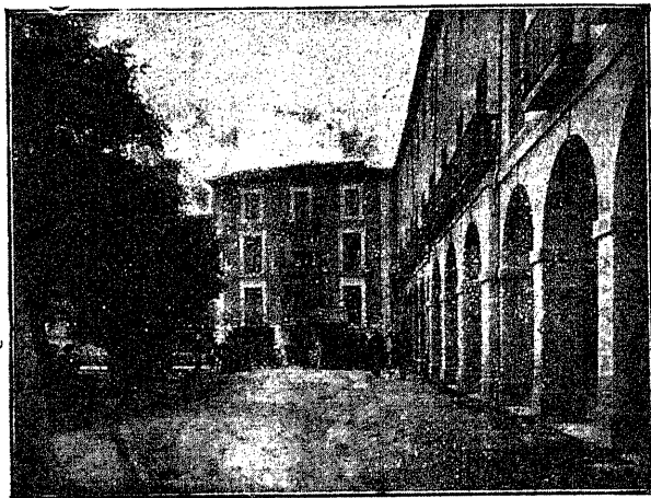
Entrada principal del Establecimiento y casa llamada de «Los Arcos».
