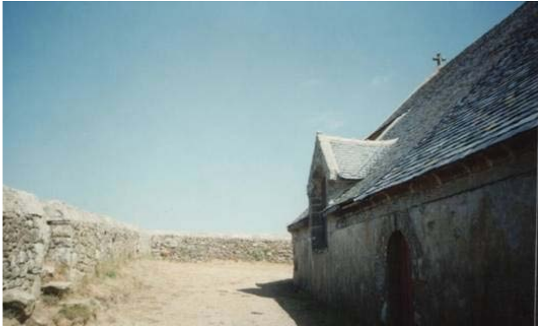
Figura 12: Fachada Norte, con su entrada.
