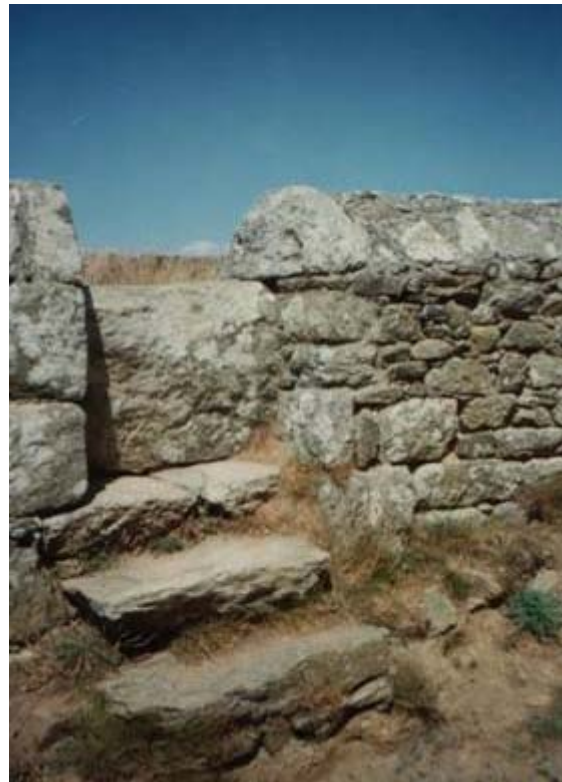
Figura 13: Muro del recinto. Entrada Norte.
