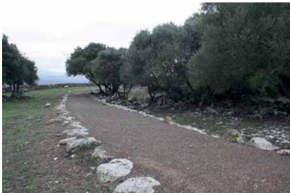
Fig. 5. Serri, percorso in terra stabilizzata nell’area archeologica di Sana Vittoria (foto M. Cogoni)
