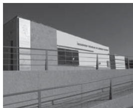
Figura 5. Vista exterior del Centro de Visitantes
