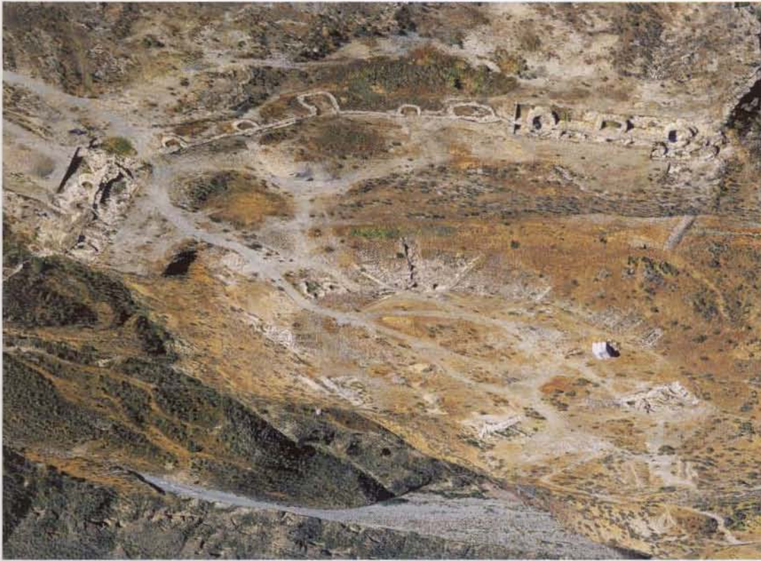
Durante el Calcolítico se desarrollaron importantes poblados fortificados, algunos realmente complejos como el de Los Millares, que contaba con tres franjas paralelas de muralla, las cuales cerraban las seis hectáreas que ocupaba la ciudadela. Vista aérea del yacimiento de Los Millares.
