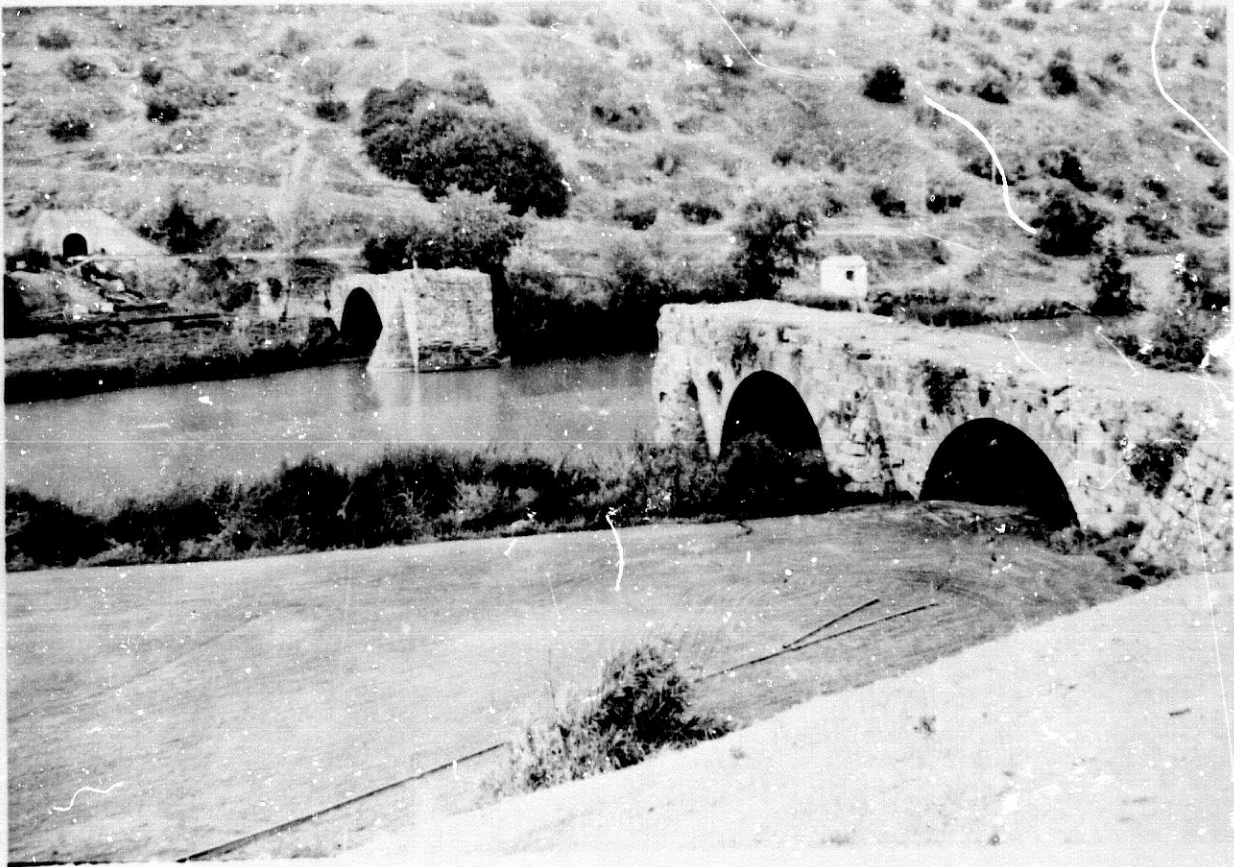
Puente Quebrada sobre el rio Guadalimar, construido con piedras de Castulo, algunas con inscripciones y labores.
